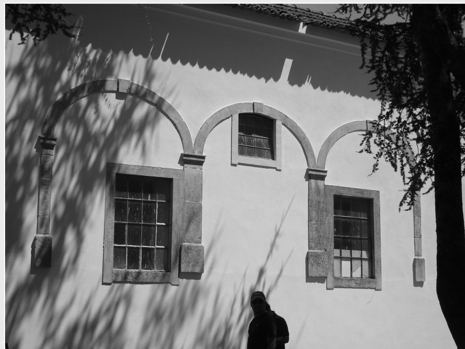
Fig. 08 – Vãos encimados por arcos de descarga (Cantanhede)
