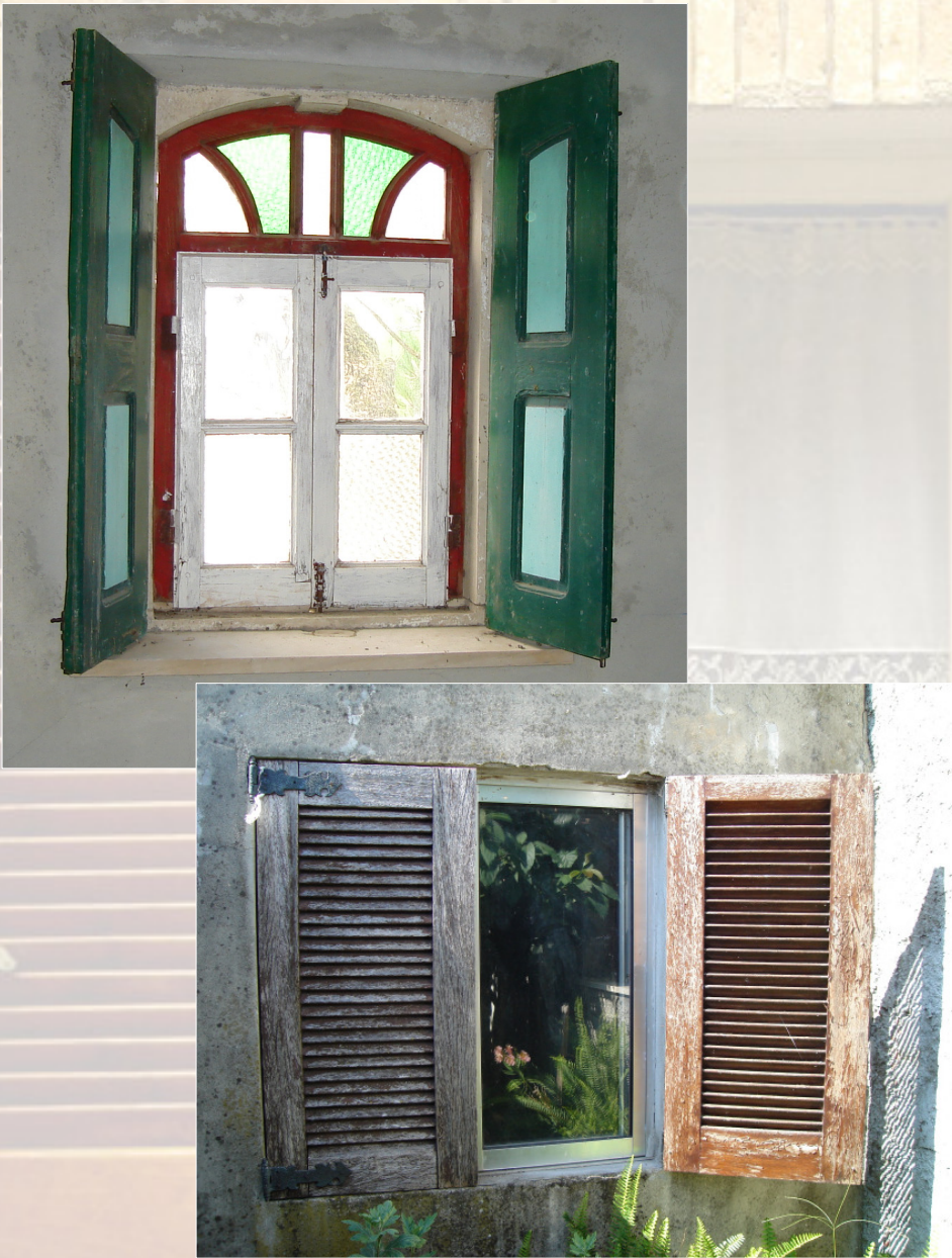
Fig. 01 / 02 – Janelas resguardadas por portadas de madeira (Gesteira, Cantanhede): uma janela tradicional com caixilharia de madeira e sistema de portadas pelo interior / uma janela mais recente com caixilharia de alumínio e sistema de portadas pelo exterior
