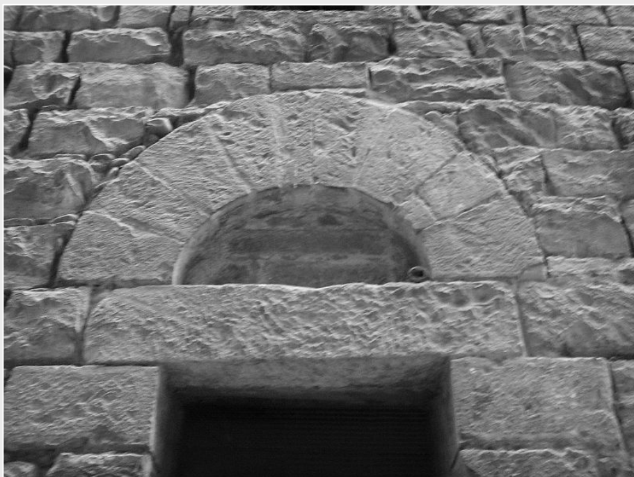
Fig. 06 / 07 – Vãos encimados por lintéis e arcos de descarga
