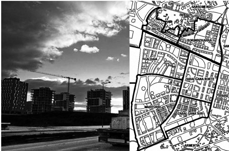
Figura 19. Construção do novo bairro de Zabalgana (expansão residencial).
