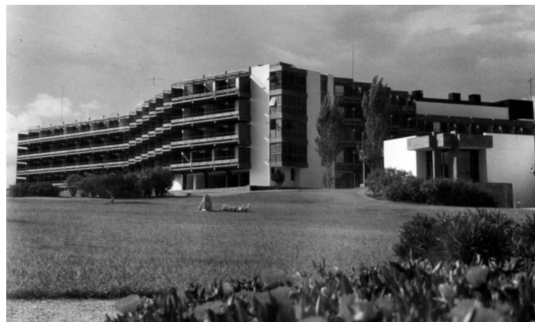
51. Corpo dos quartos visto de Sul
