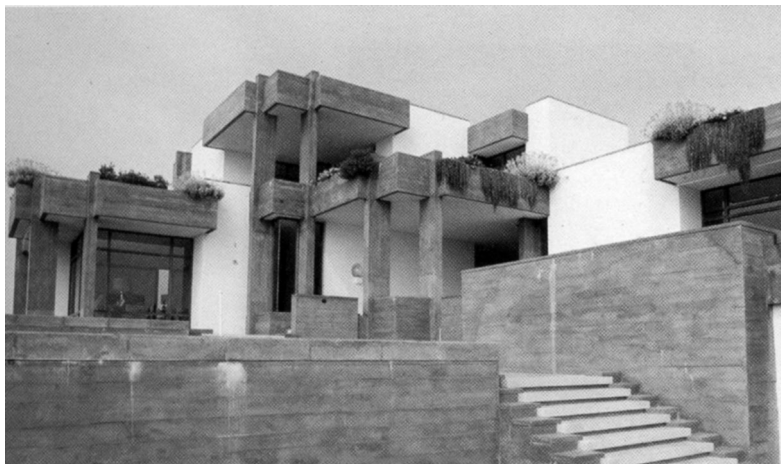
52. Salas do piso inferior no topo sul
