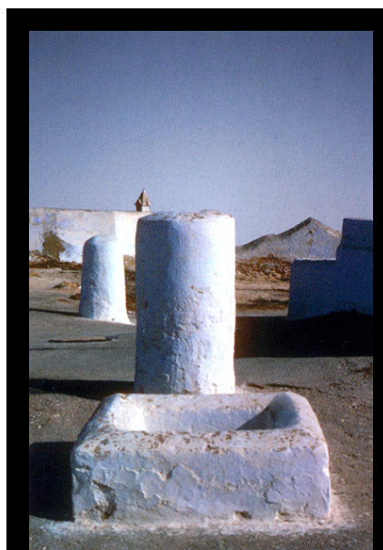
Fig. 19 – Chaminés de ventilação em habitação troglodita em "cueva de la Torre", Paterna
