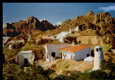
Fig. 75 – Habitações de carácter misto, escavadas e completadas com acrescentos, Guadix
