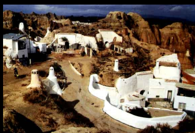
Fig. 77 – Vista das habitações e destaque das construções pintadas a branco, Guadix
