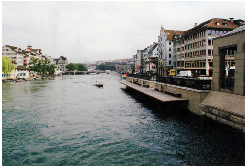
Fig. 68, 69, 70_ Aparentamentos marginais alternativos: estrutura de madeira avançada sobre a água, solucionando a falta de espaço. Acessos à água; requalificação de espaço público marginal.
