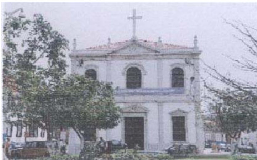
Figura 3 - Exterior da Igreja de Nossa Senhora da Graça (Praia), onde Amílcar Cabral foi baptizado (foto tirada pelo autor).
