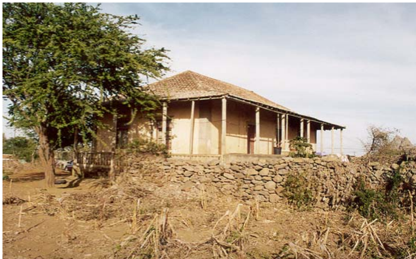
Figura 6 - Aspecto exterior da casa de Achada Falcão (foto gentilmente cedida por Lúcio Cunha).
