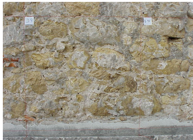
Aspecto do aparelho utilizado no registo inferior esquerdo da Sondagem G1 (foto Nuno Santos).
