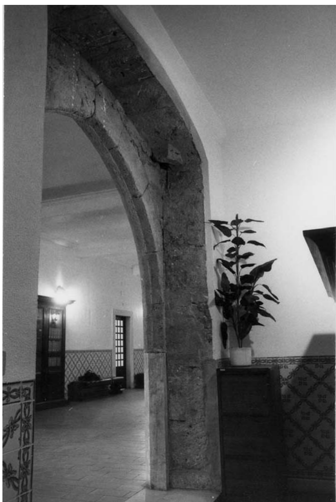
Perspectiva da estrutura interna da porta de arco quebrado.
