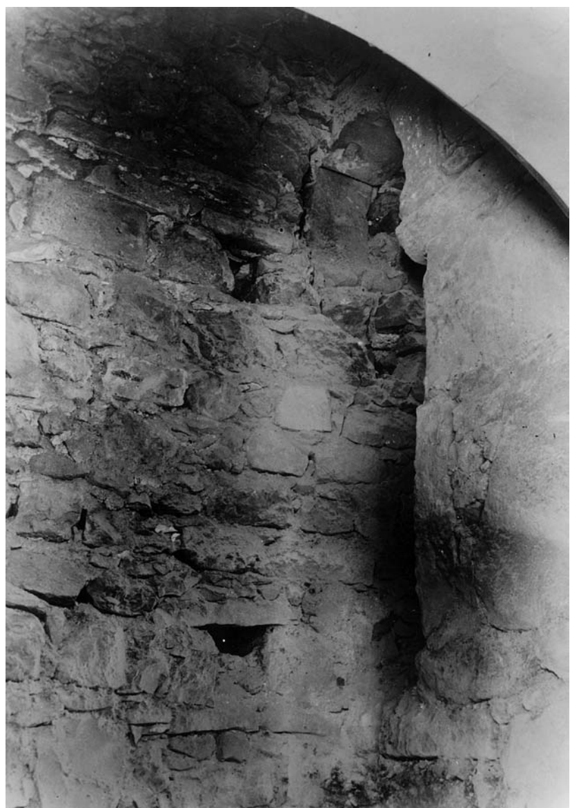
Vão de arco ultrapassado no paramento interno do torreão sul da porta-forte (DGEMN, foto 117).
