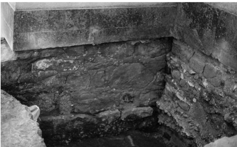
Aspectos da Sondagem A2 , observando-se a muralha sul sob o gigante oriental da Capela e o paramento interno da mesma.
