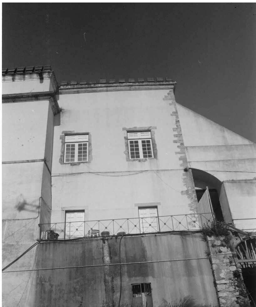
Aspecto da ala ocidental com as janelas altas de verga recta.
