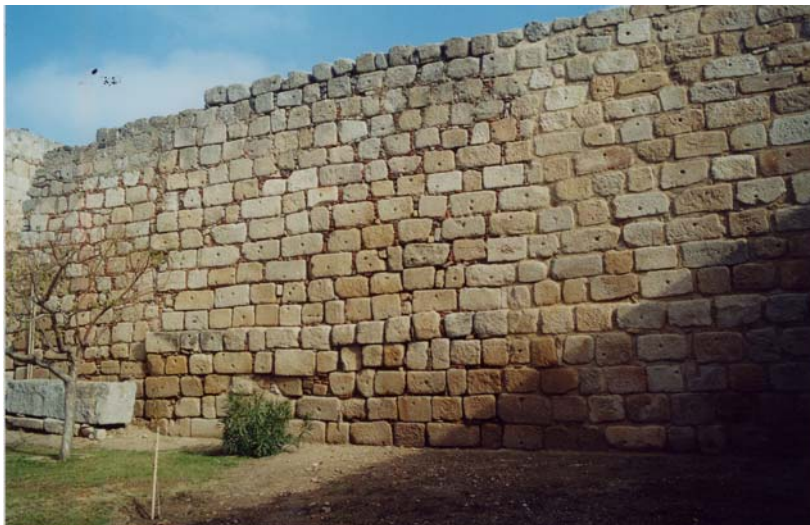
Aspecto das muralhas do Conventual de Mérida, ilustrando a reutilização, em grande extensão, dos silhares romanos provenientes das muralhas destruídas.
