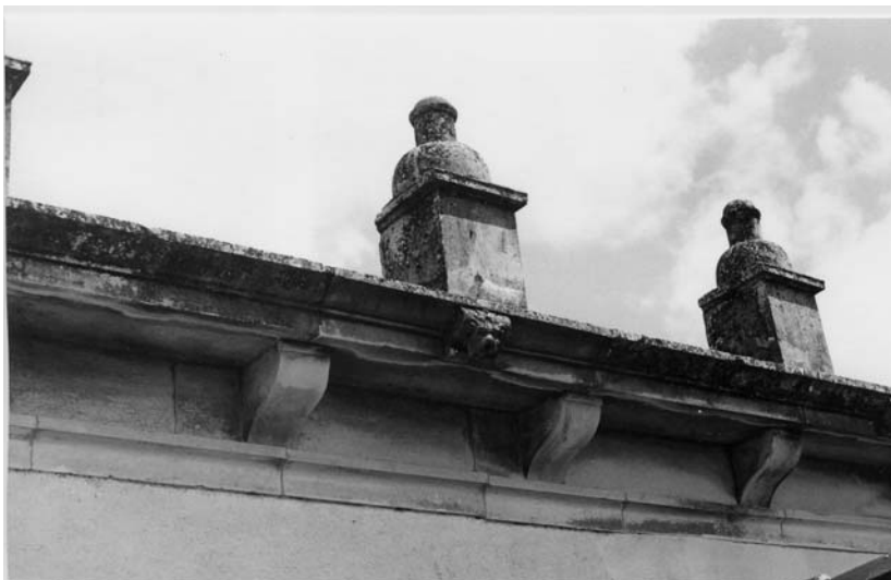
Detalhe da cornija modilhonada e do sistema de ameias.
