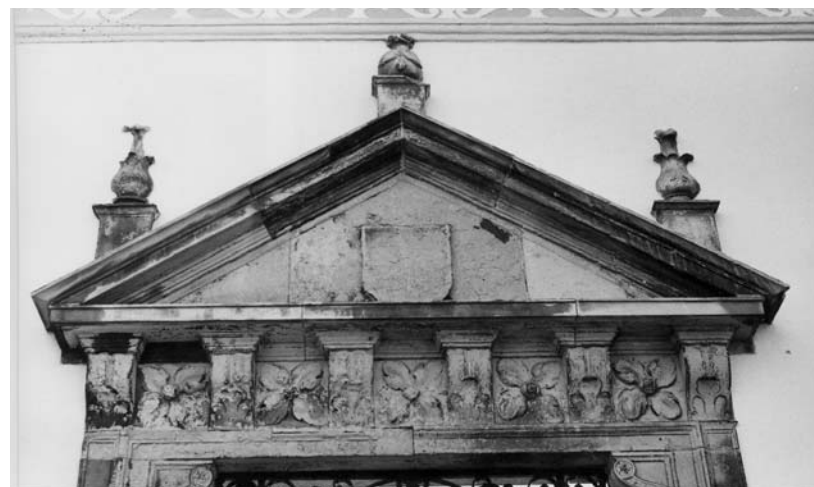
Cornija modilhonada do frontão do portal da Casa dos Melos.
