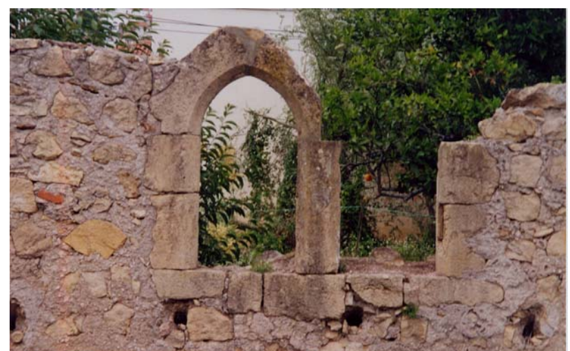
Aspecto das janelas subsistentes do Paço da Rainha em Santa Clara-a-Velha.
