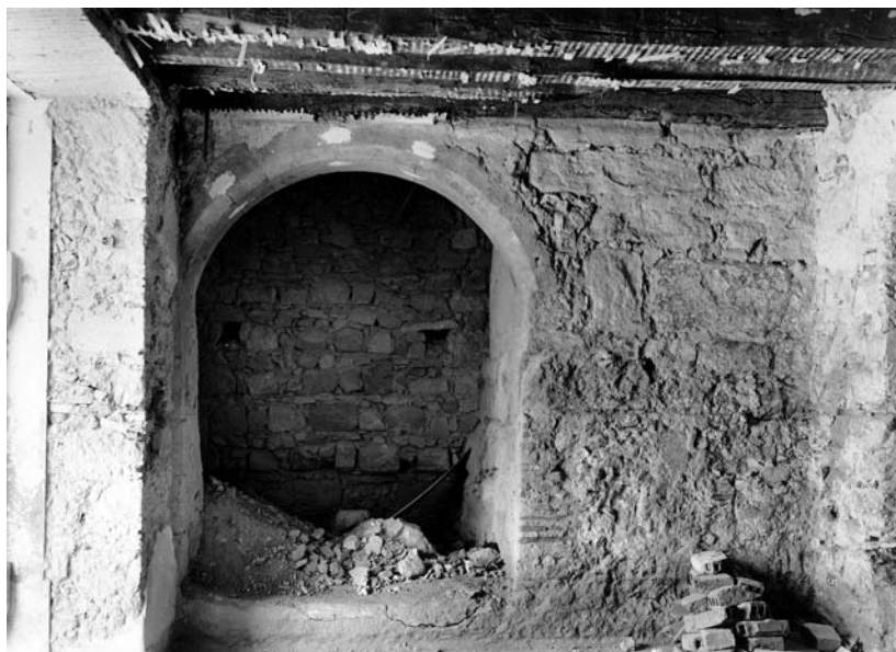
Paramento interno do torreão sul da porta-forte (DGEMN, foto 114).
