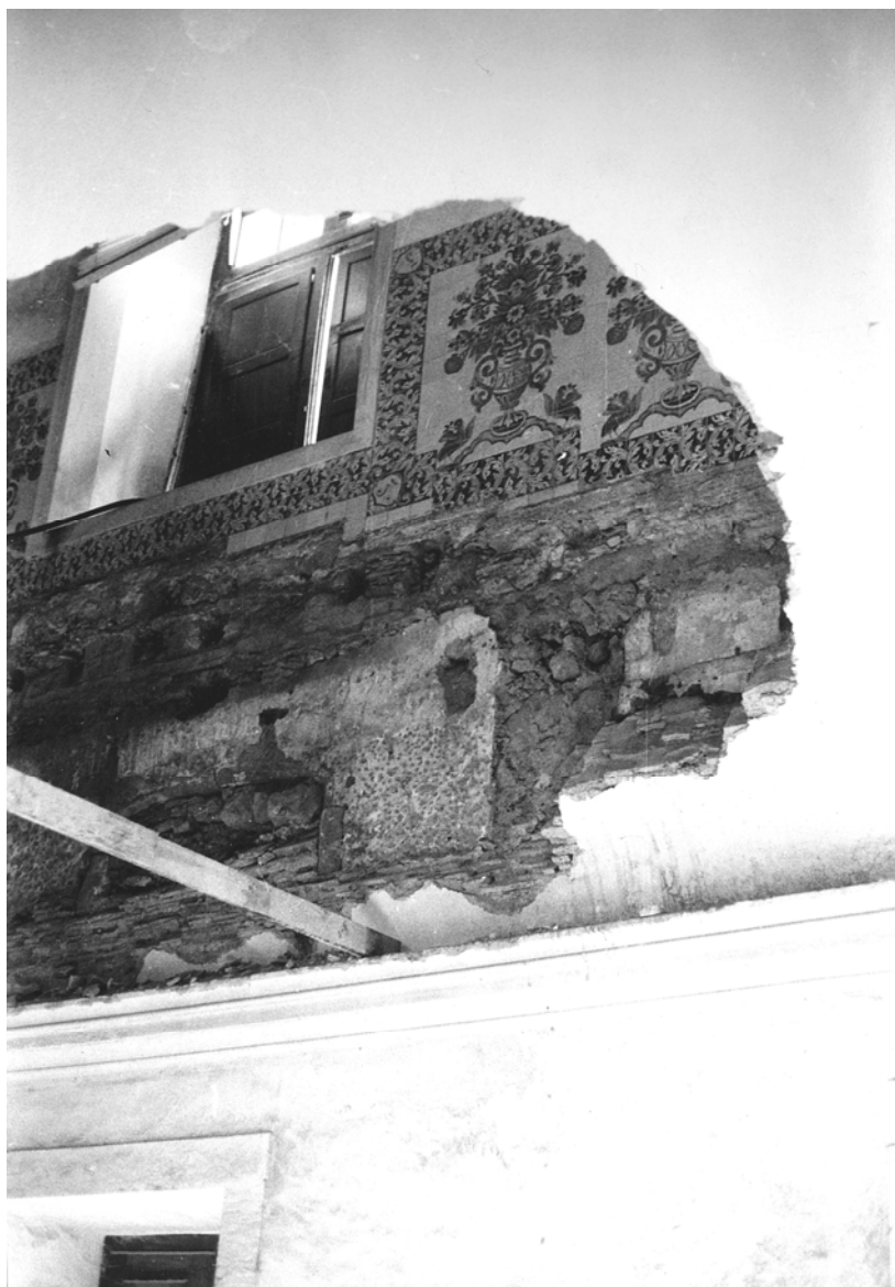
Aspecto das janelas desvendadas no topo da ala poente perpendicular ao Paço, no decurso das intervenções da década de 40 (DGEMN, foto 398).
