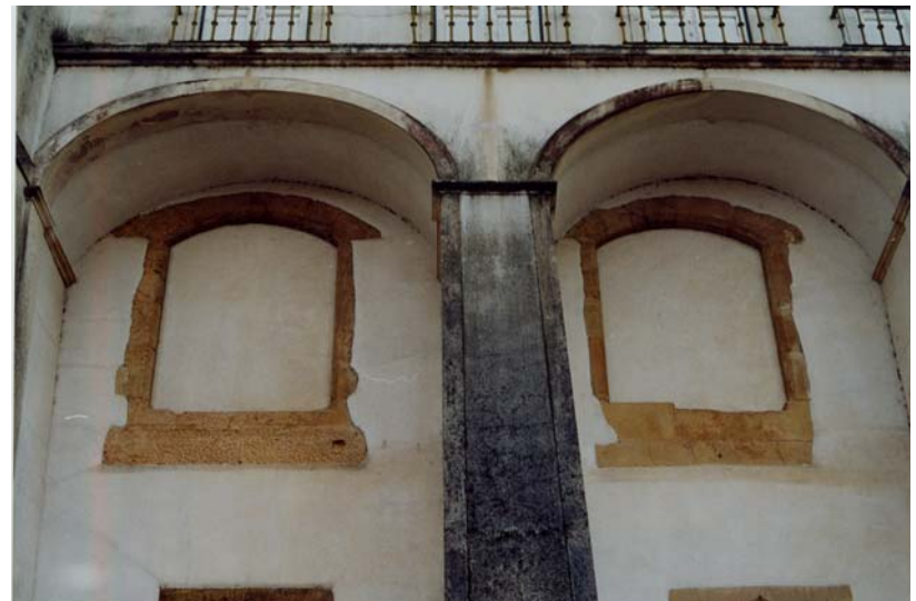
Janelas da Sala Grande desvendadas na fachada norte.
