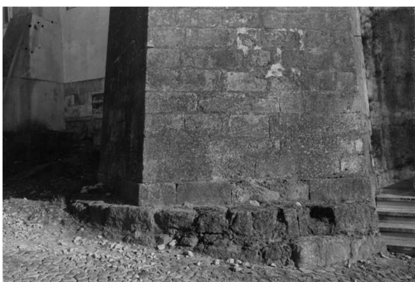
Base do 5º cubelo da fachada norte (sentido este/oeste).
