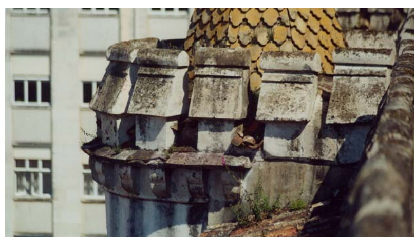
Pormenor da cimalha num dos cubelos da fachada norte.
