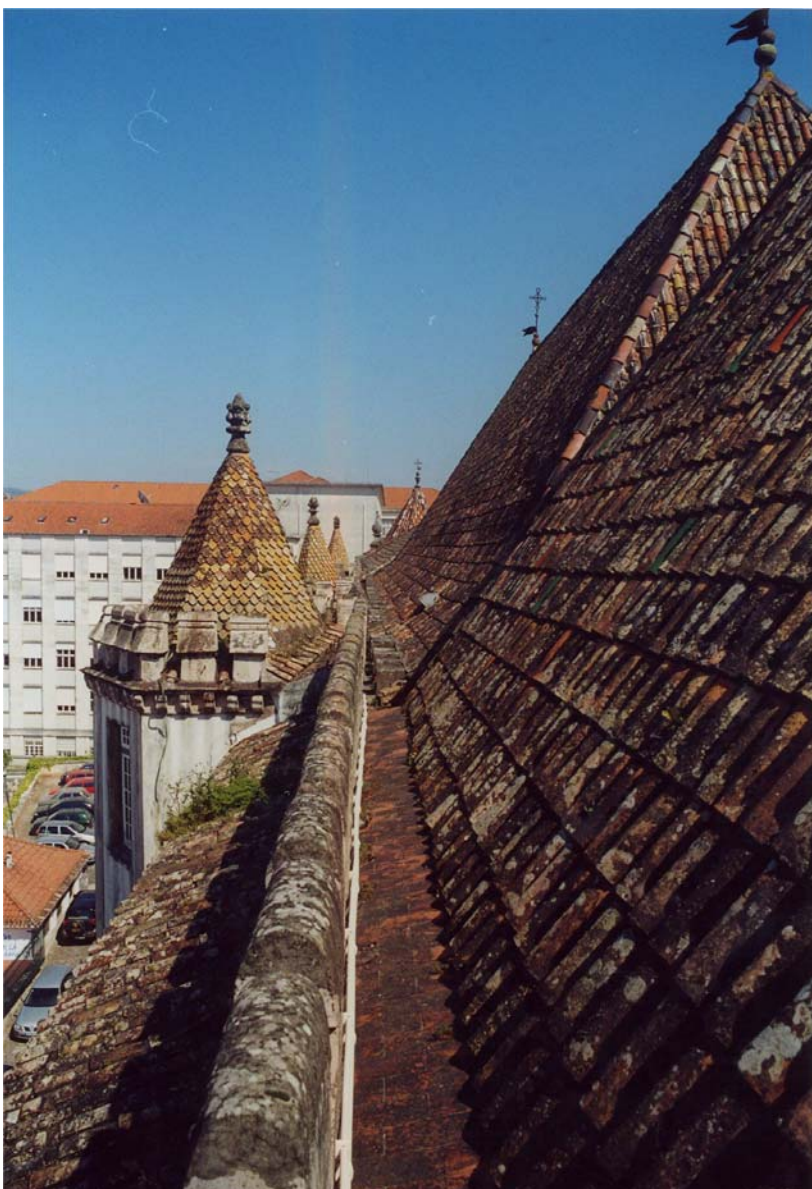
Perspectiva dos remates dos coruchéus dos cubelos da fachada norte.
