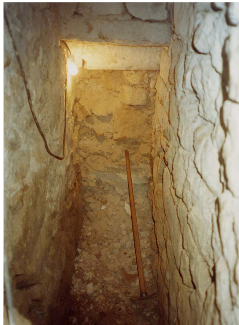
Cubelo norte da porta-forte. Aspecto do corredor parcialmente liberto de entulho.
