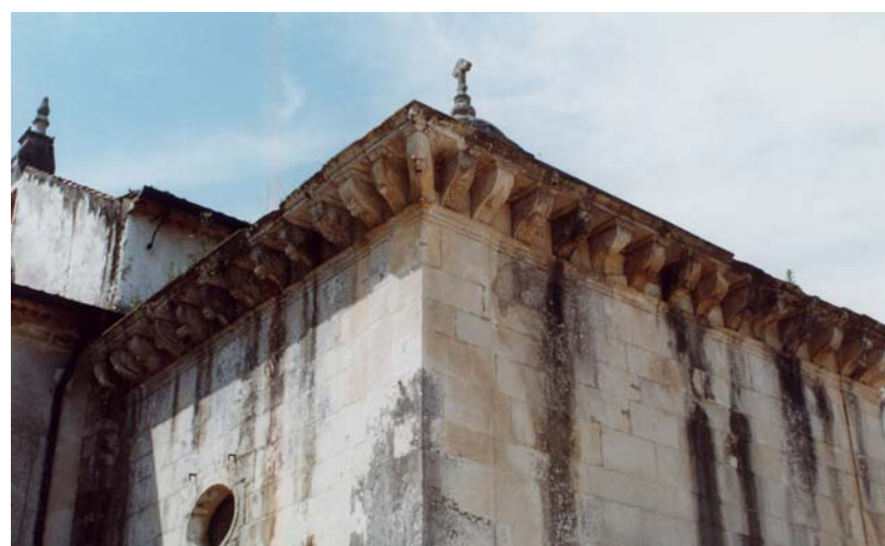
Cornija modilhonada da Capela dos Reis Magos da Igreja do Mosteiro de S. Marcos.
