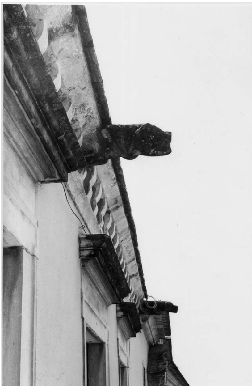
aspecto das gárgulas sobre os aposentos dos Infantes, no interior do pátio.
