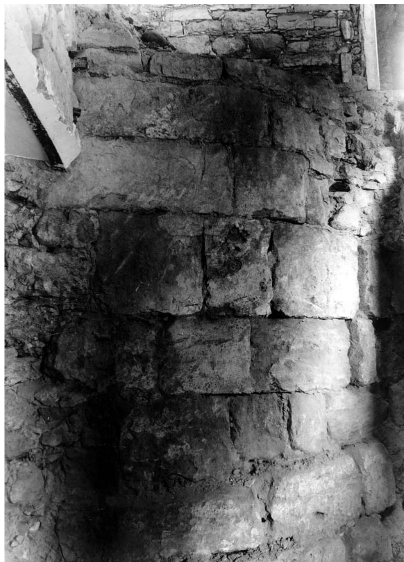
Aspecto do cubelo de sudeste demolido (DGEMN, foto116).
