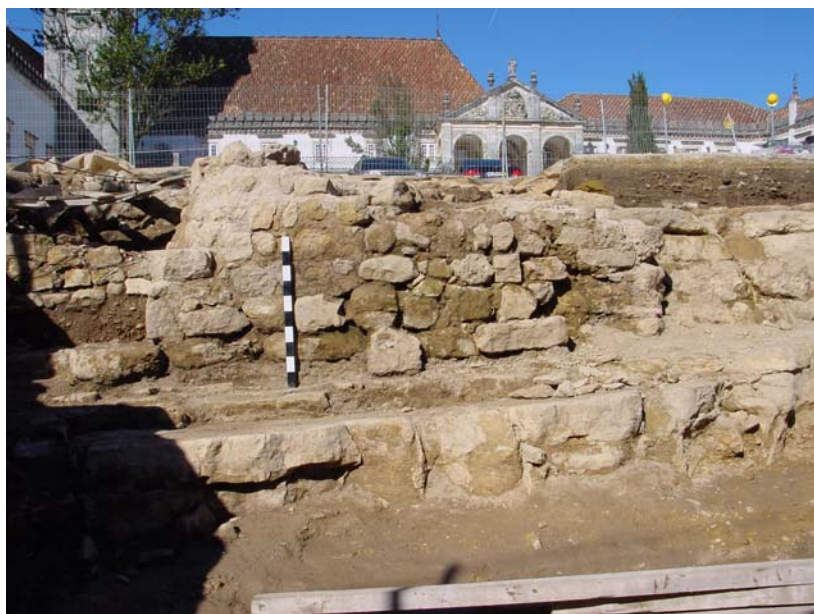
Aspecto da muralha sul e respectiva torre.
