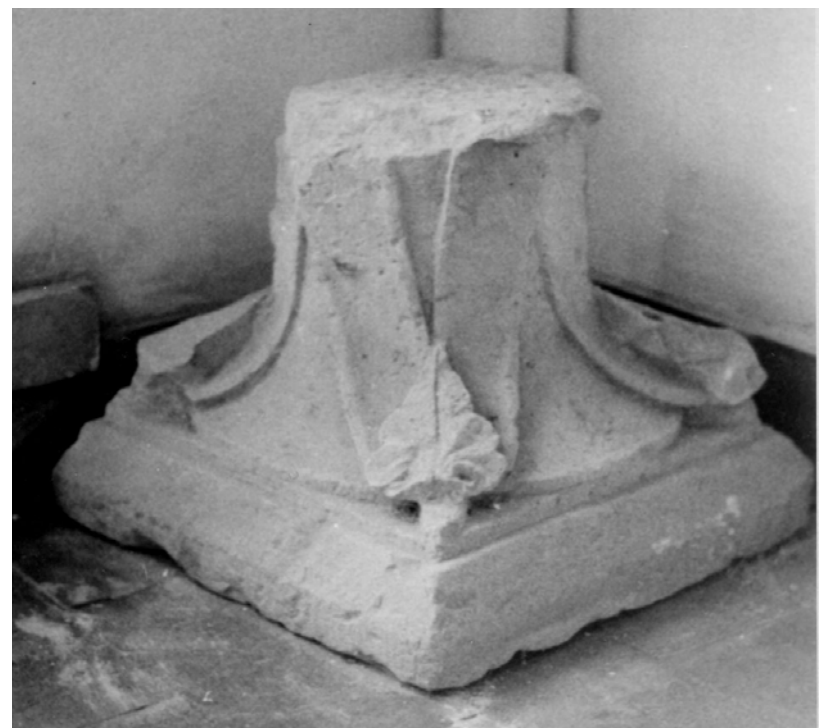
Capitel localizado na década de 1980, durante as obras de ligação do piso térreo da ala norte do Paço ao claustro dos Gerais .
