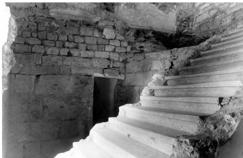
Trecho da muralha perpendicular às fachadas do Colégio de S. Pedro, ilustrando a refeitura do seu paramento após a conquista da cidade por Fernando Magno (DGEMN, foto 119).
