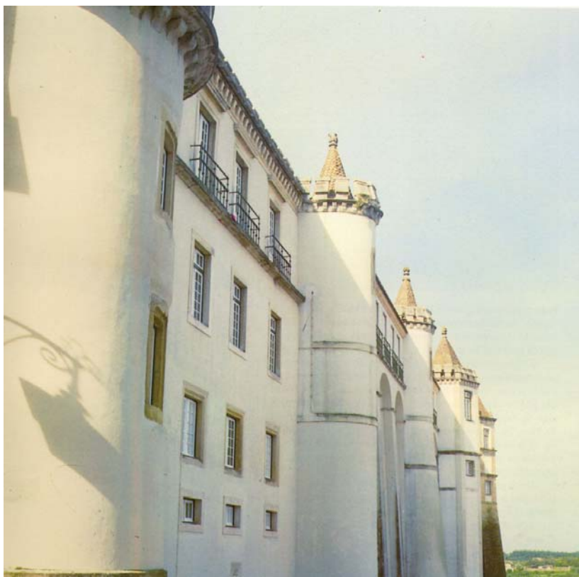
Aspecto da fachada norte.
