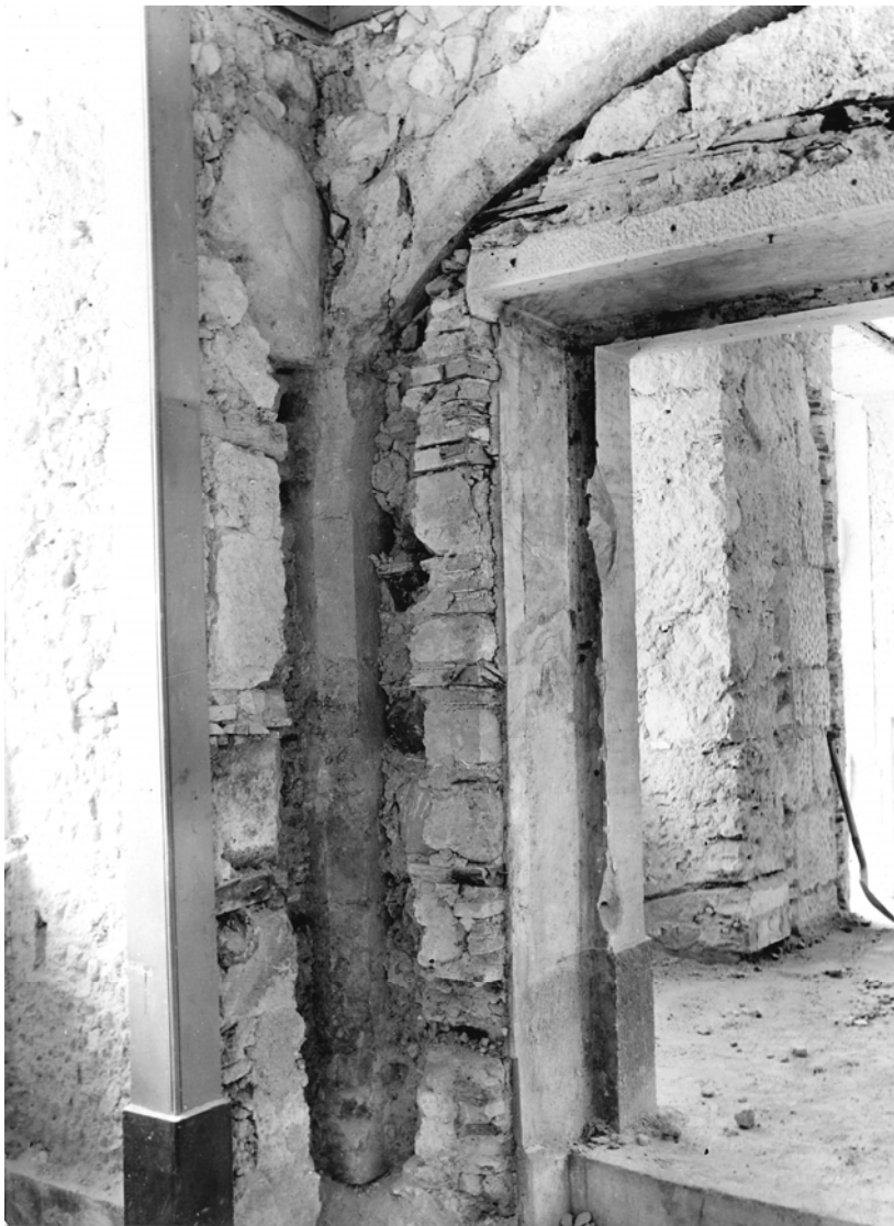
Pormenor do encontro desses arcos com a estrutura da arcaria oculta pela actual fachada (DGEMN, foto 108).
