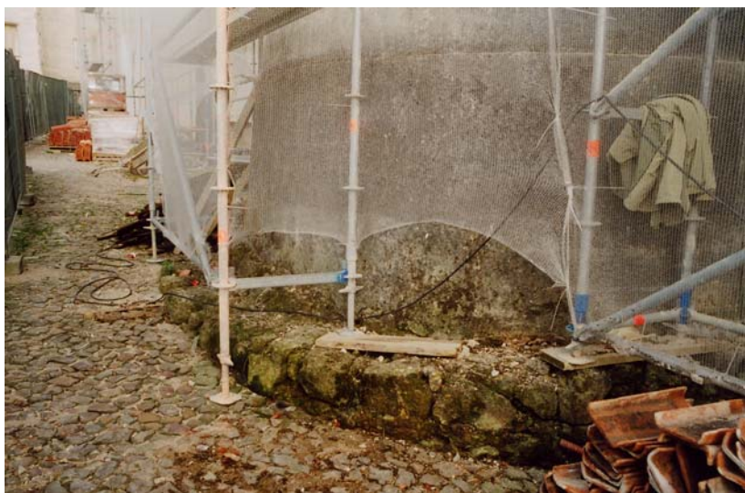
Base do 3º cubelo da fachada norte (sentido este/oeste).
