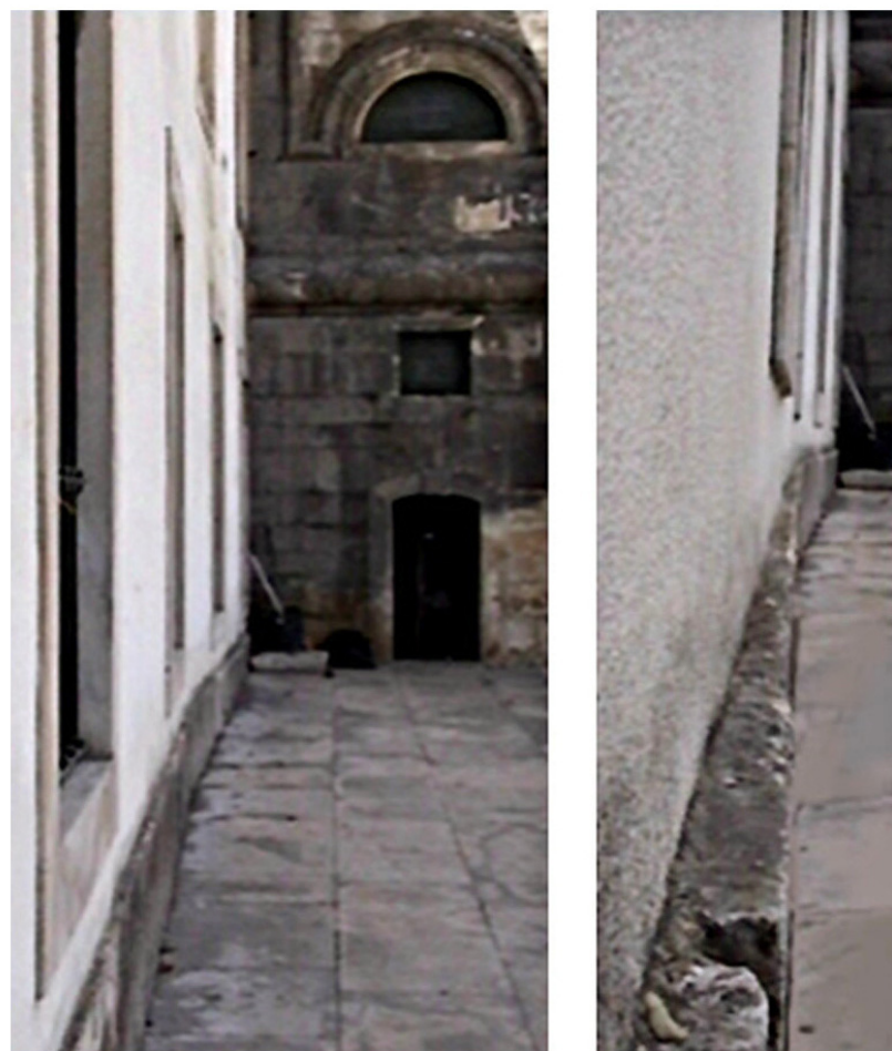
Aspecto da fachada oriental dos Gerais , ostentando a deformação do seu alçado (José Luís Madeira).
