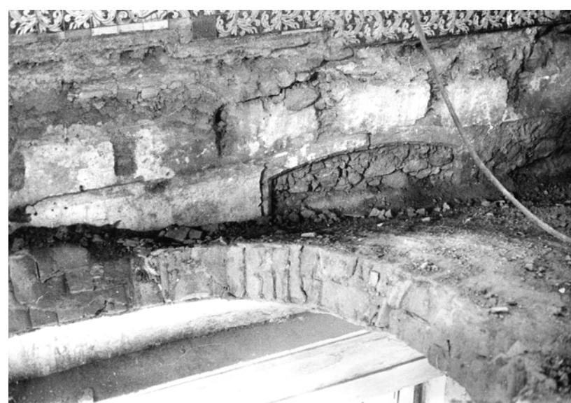
Outros aspectos das mesmas janelas (DGEMN, fotos 405 e 404).
