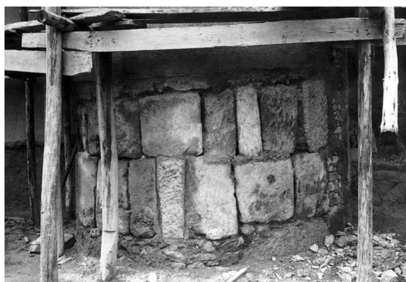
Base do 2º cubelo (sentido este/oeste) da fachada norte, desprovido de reboco, durante a intervenção da década de 40 (DGEMN, foto 209)
