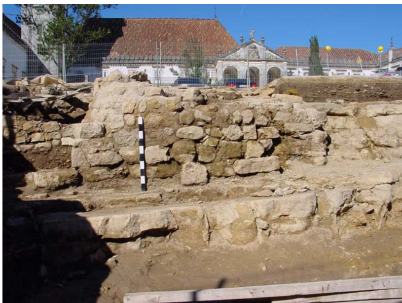
Aspecto da muralha sul e respectiva torre.
