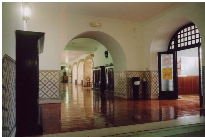
Arco transverso de sustentação da parede oriental da Sala Grande.
