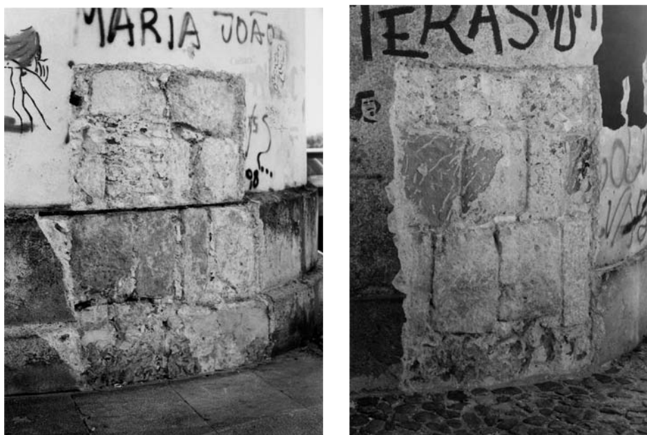
Aspectos das Sondagens C1 e C2
