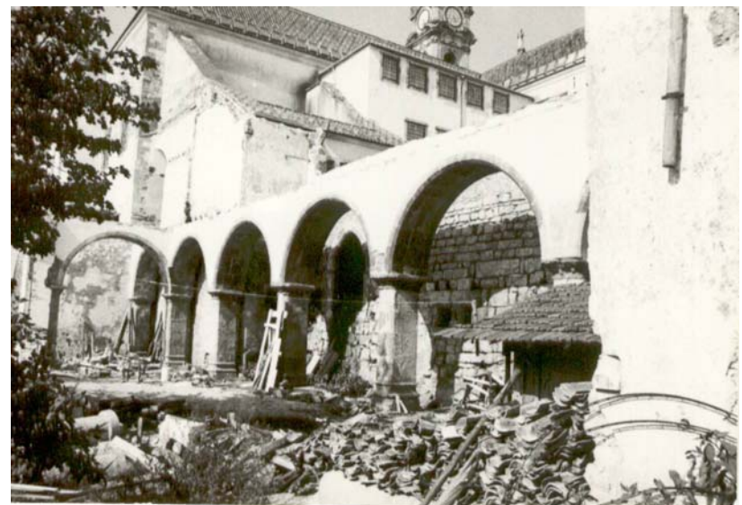
Arcarias do antigo depósito da sala de leitura da Biblioteca, após a demolição deste (DGEMN, foto 516).
