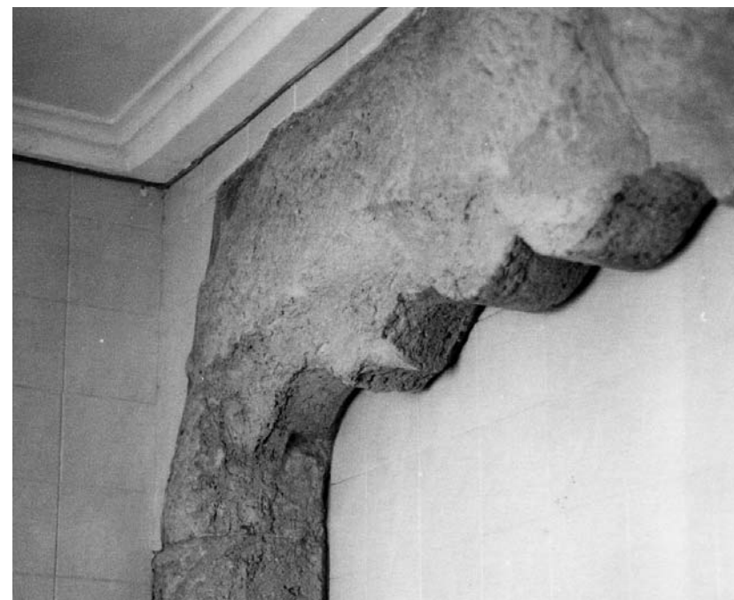
Primitivo vão de acesso acesso ao interior do nível superior do 2º cubelo da fachada norte (sentido este/oeste).
