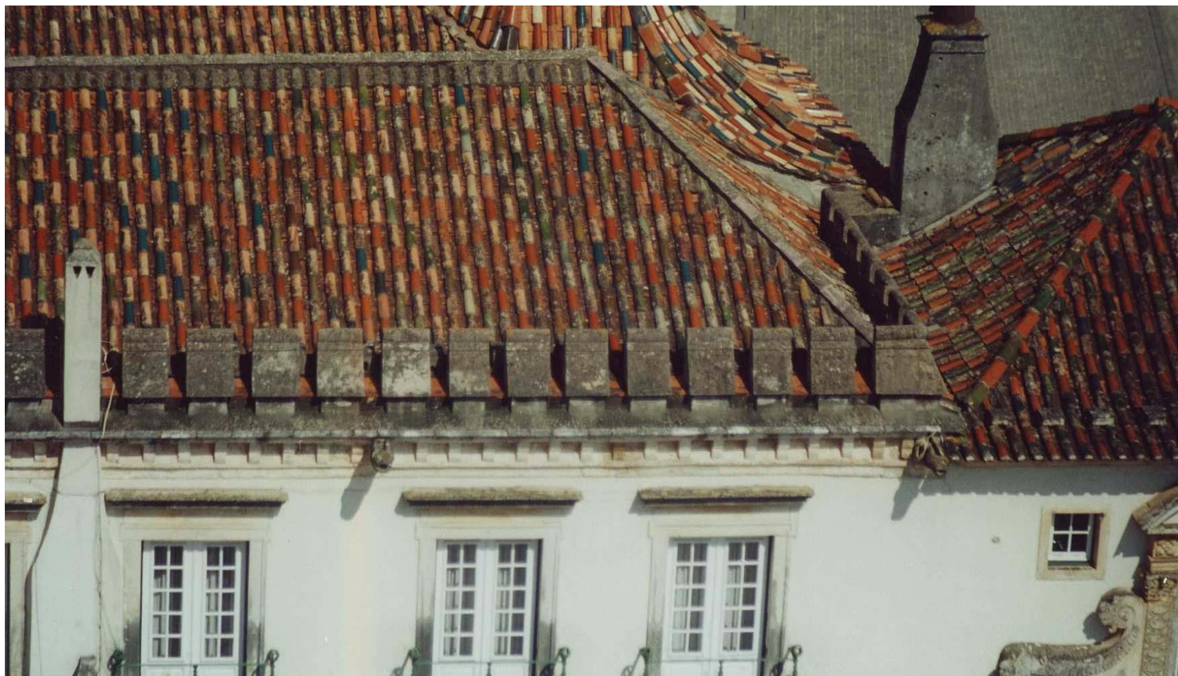
Perspectiva da união dos telhados entre a Reitoria (aposentos dos Infantes) e o Colégio de S. Pedro (zona do antigo eirado).
