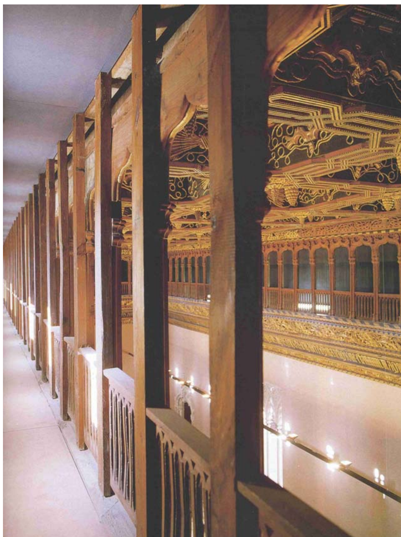
Corredor da cobertura da Sala dos Reis Católicos no Palácio de La Aljafería.
