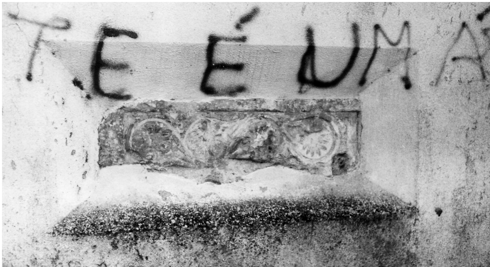
Pedra ornamentada visigótica incorporada na fachada norte.
