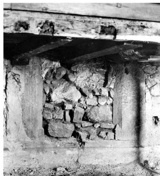
Aspecto dos trabalhos na Sala dos Capelos após a remoção do pavimento, em 1944, vendo-se o local onde seriam desvendados os dois vãos medievais e detalhes do vão decorado de pérolas e do vão de aresta chanfrada (DGEMN, fotos 195, 197 e 193).
