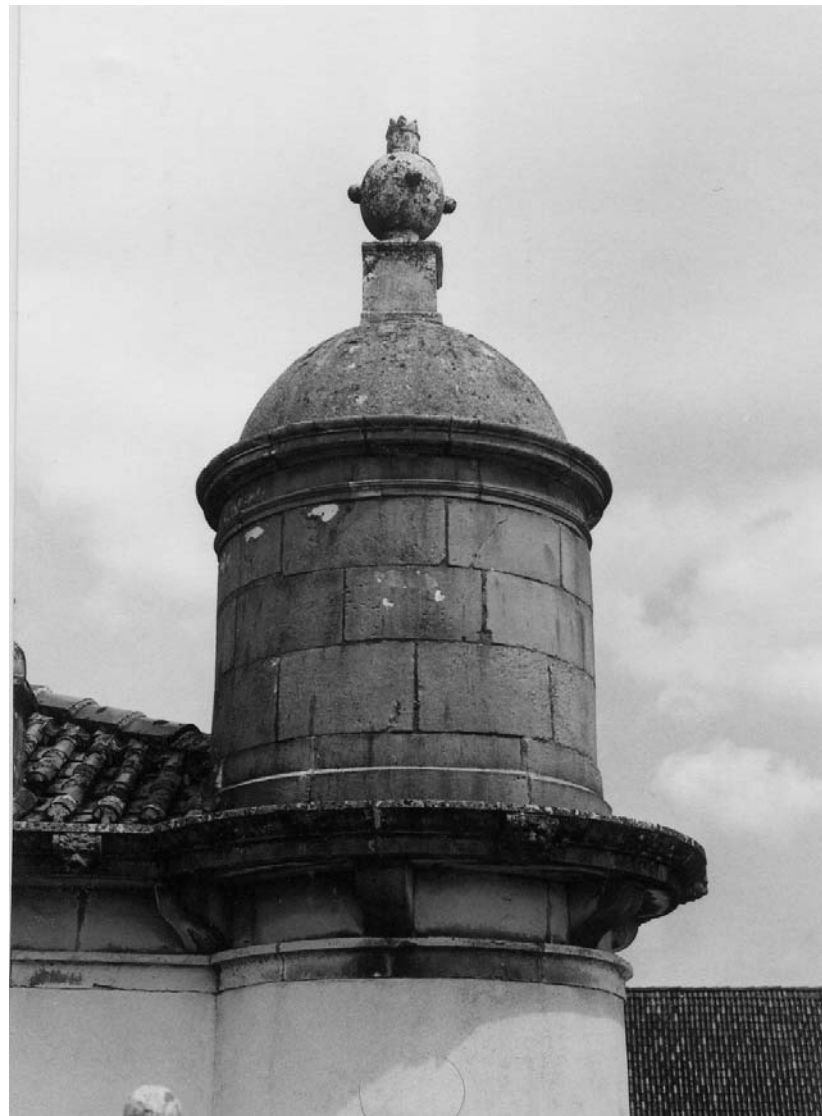
Aspecto de um dos elementos de remate dos contrafortes.
