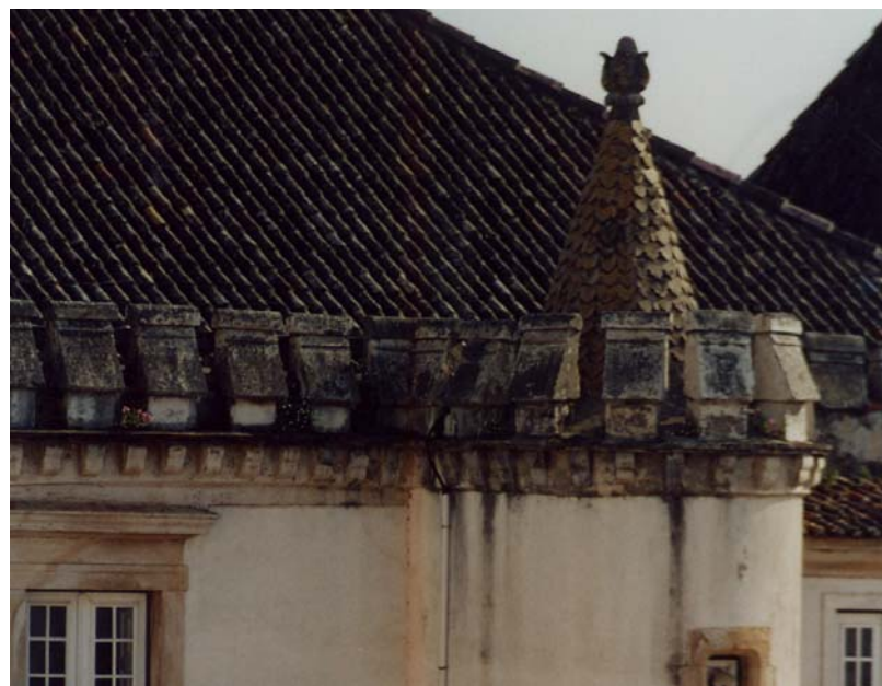
Aspecto da cimalha na fachada norte.
