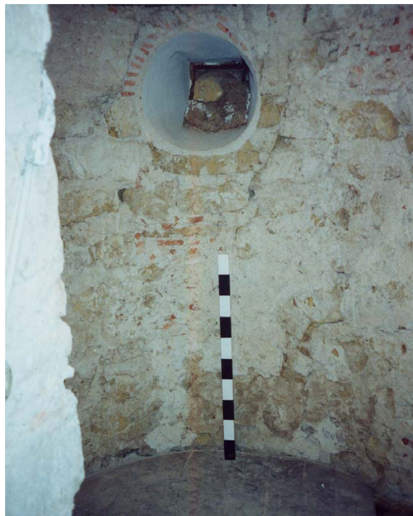
Aspecto interno do cubelo norte da antiga porta-forte.
