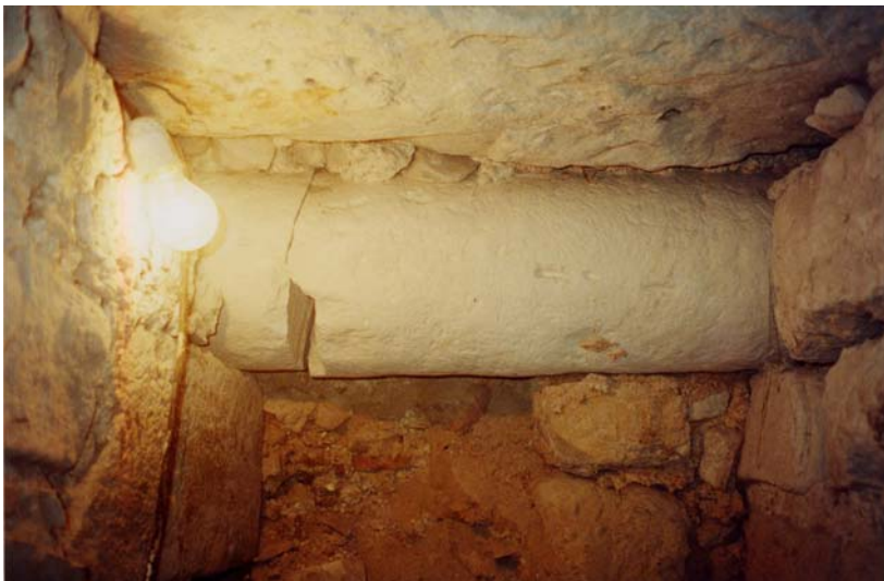
Fuste de coluna utilizado como degrau de escada, localizado no interior do corredor do adarve do cubelo norte da porta-forte.
