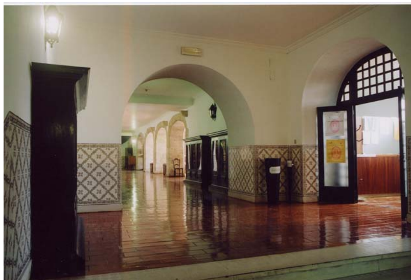
Arco transversal de suporte da parede de Sala Grande.
