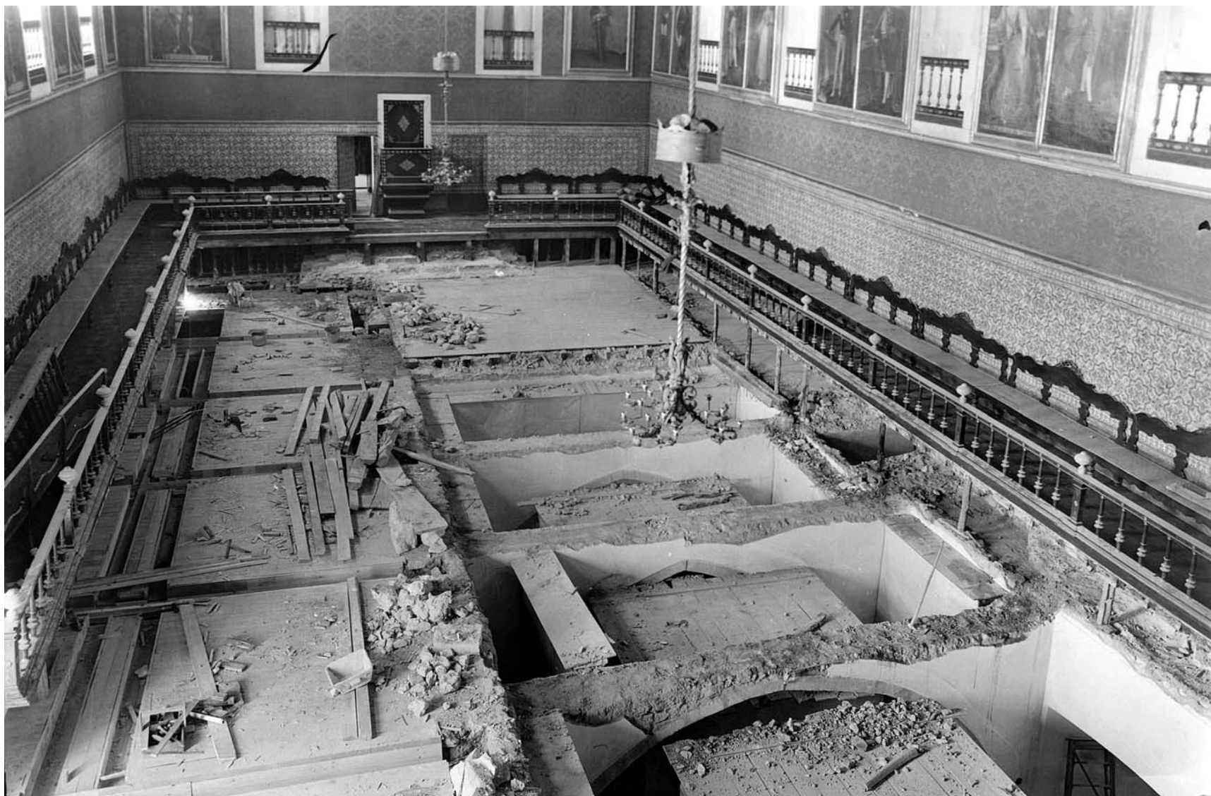
Aspecto da Sala dos Capelos após a remoção do pavimento, em 1944, ostentando a parede intermédia e a sequência de arcos quebrados do piso térreo (DGEMN, foto 20).
