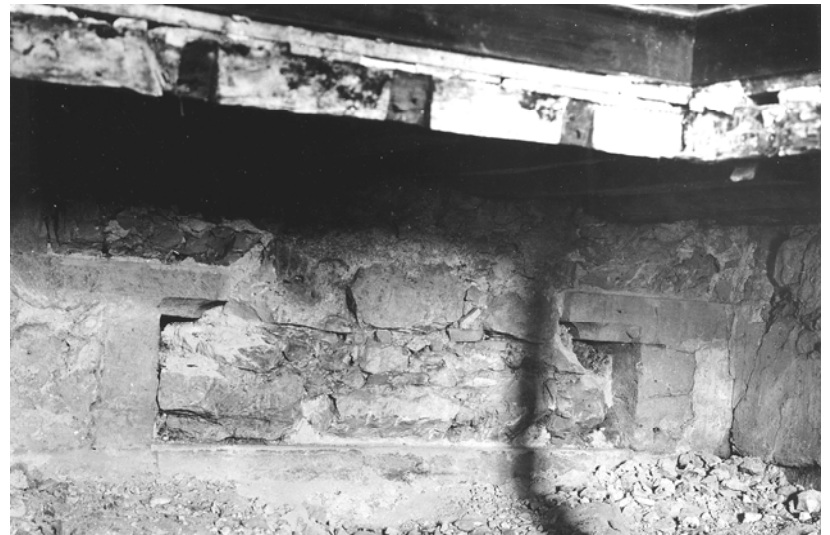
Aspecto da base de uma janela e respectivos assentos descobertos em 1944, durante o restauro da Sala dos Capelos (DGEMN, foto 773).
