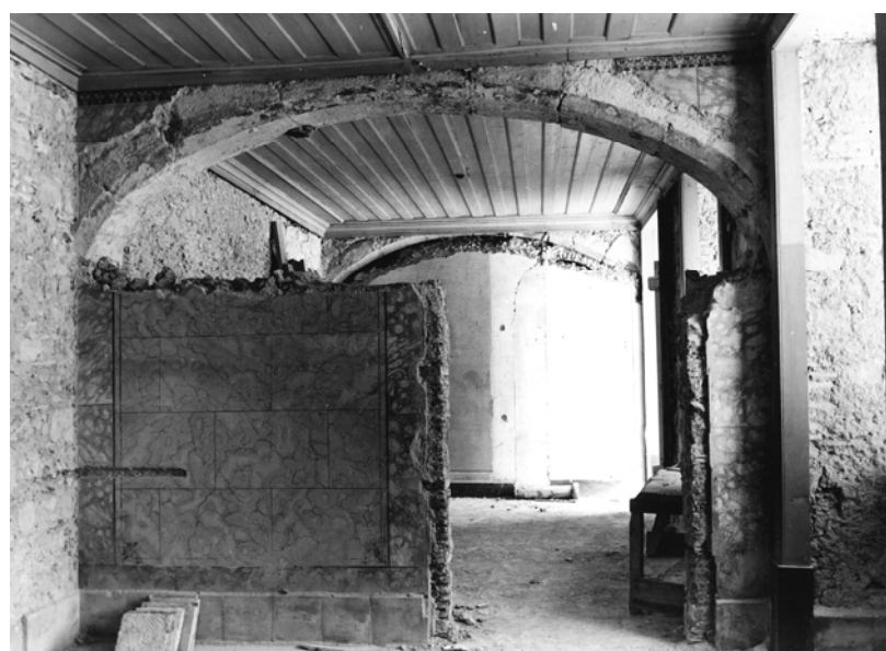
Arcos transversos localizados no piso térreo da Ala de S. Pedro , nas intervenções da década de 40 (DGEMN, fotos 174, 173 e 111).
