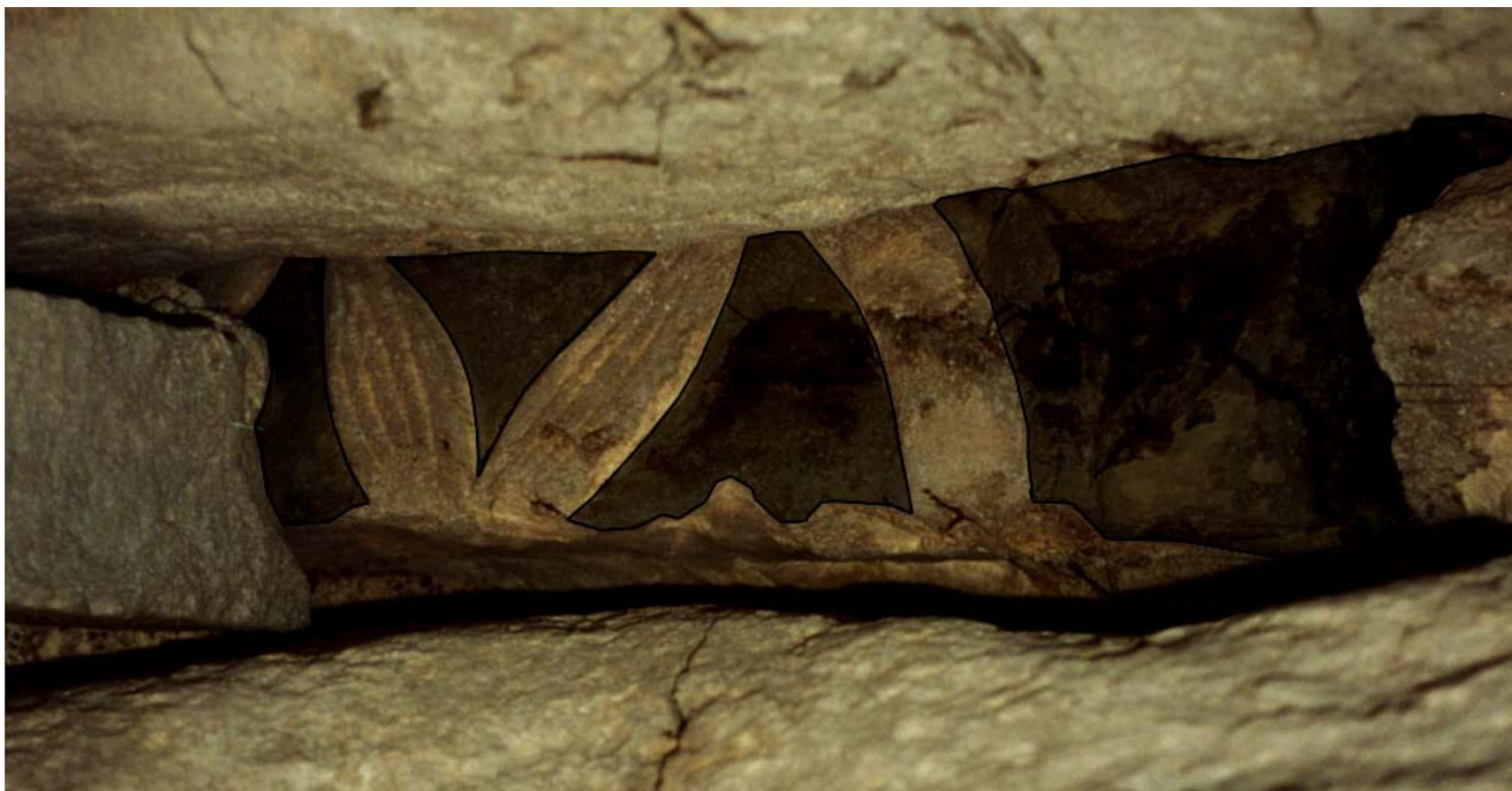
Pedra visigótica localizada no interior do cubelo norte da porta-forte.
