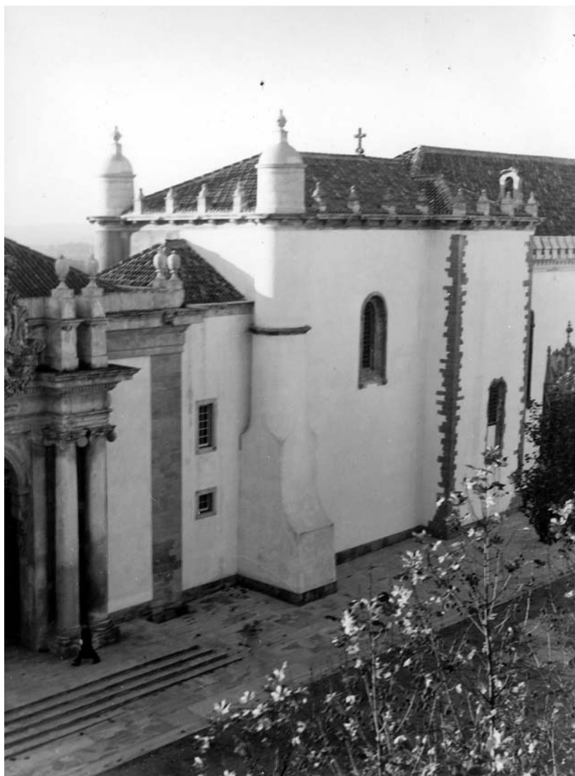
Perspectiva geral da obra de fortificação da cabeceira (DGEMN, foto 224).
