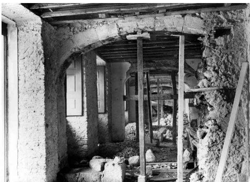
Vestígios dos arcos de suporte dos aposentos dos oficiais (DGEMN, foto 173).
