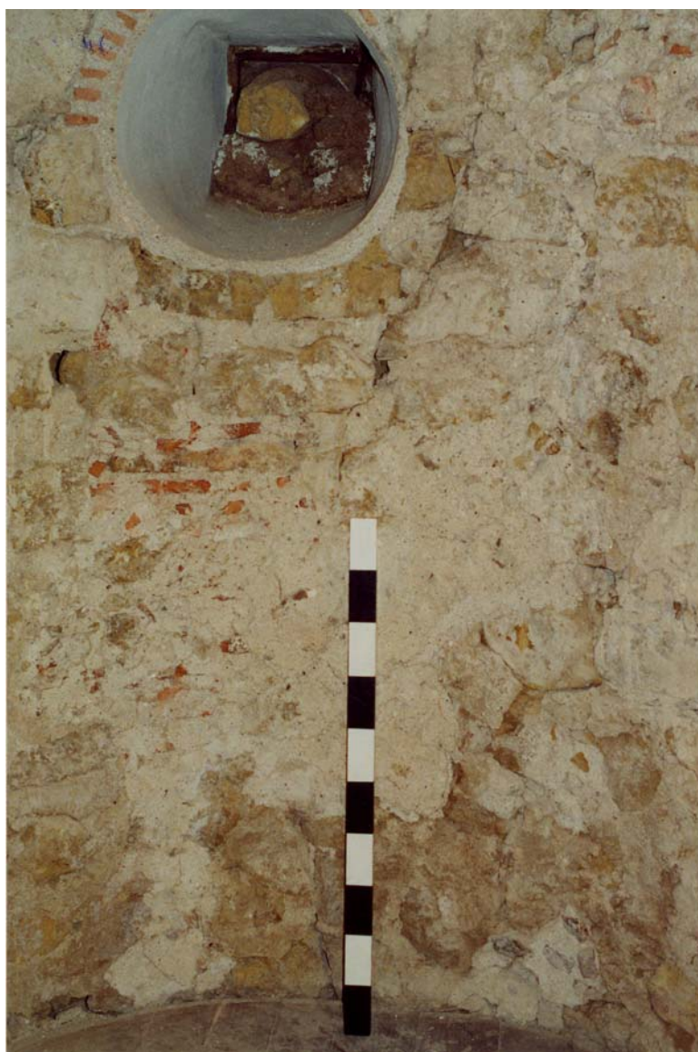
Aspecto interno do cubelo norte da porta-forte.
