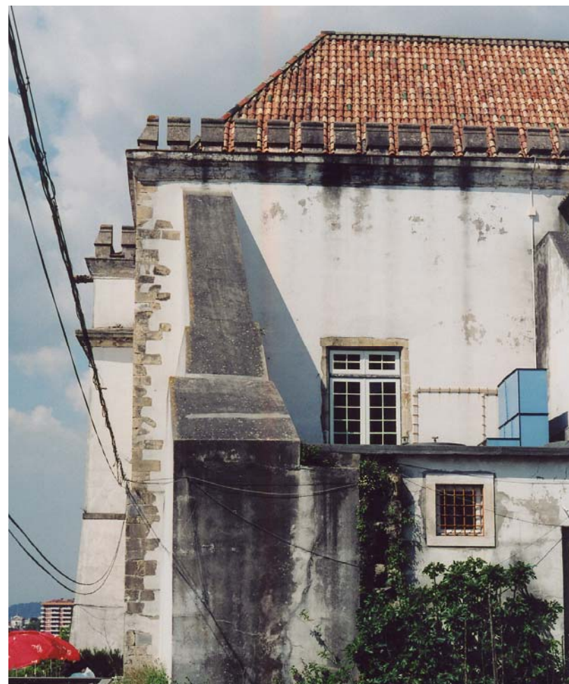
Aspecto da fachada sul do mesmo corpo, com nova janela afim das anteriores.
