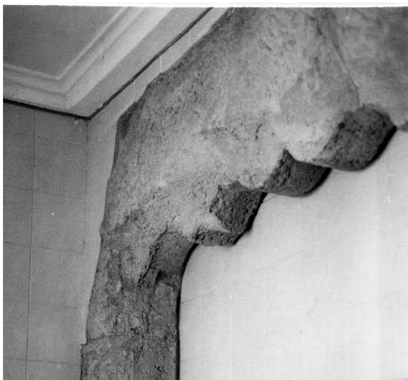
Vão realizado por Marcos Pires, subsistente no interior do segundo cubelo da fachada norte (sentido este/oeste).
