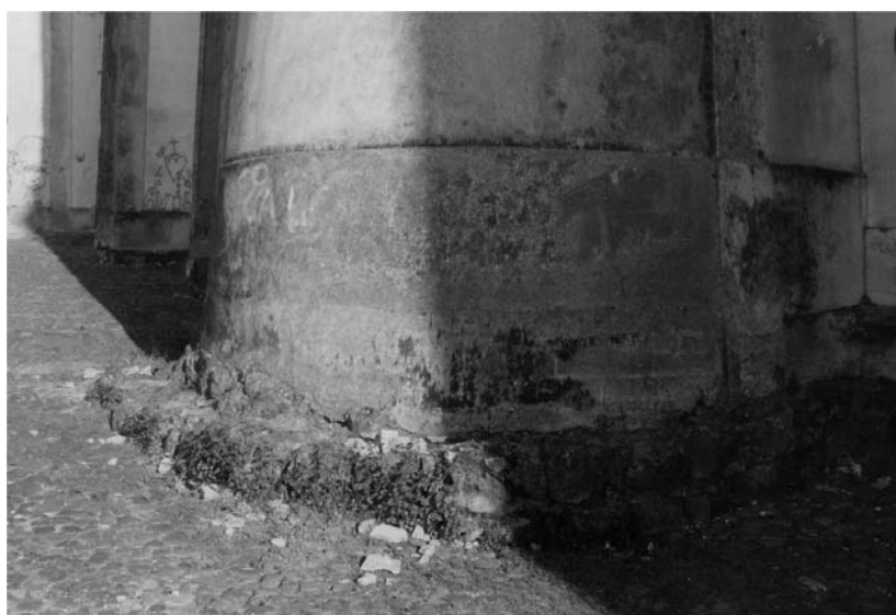
Base do 4º cubelo da fachada norte (sentido este/oeste).
