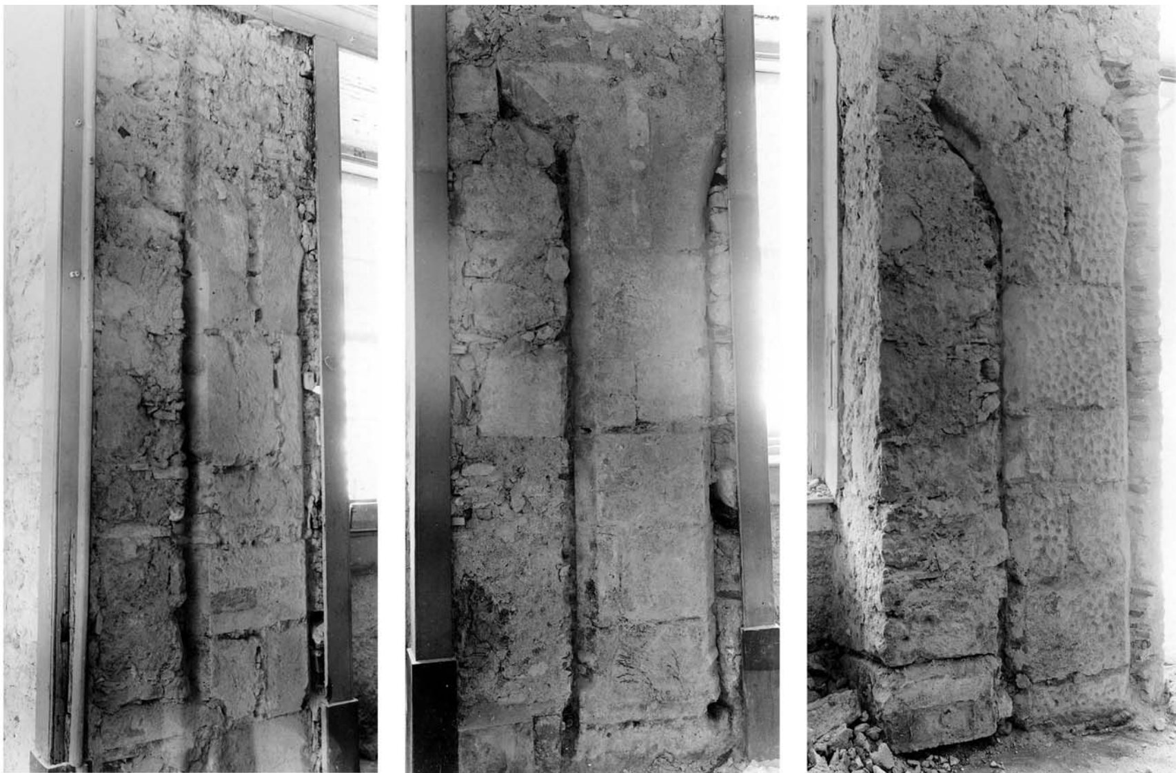
Aspectos dos arcos incorporados na fachada do Colégio de S. Pedro (DGEMN, fotos 120, 121 e 122).
