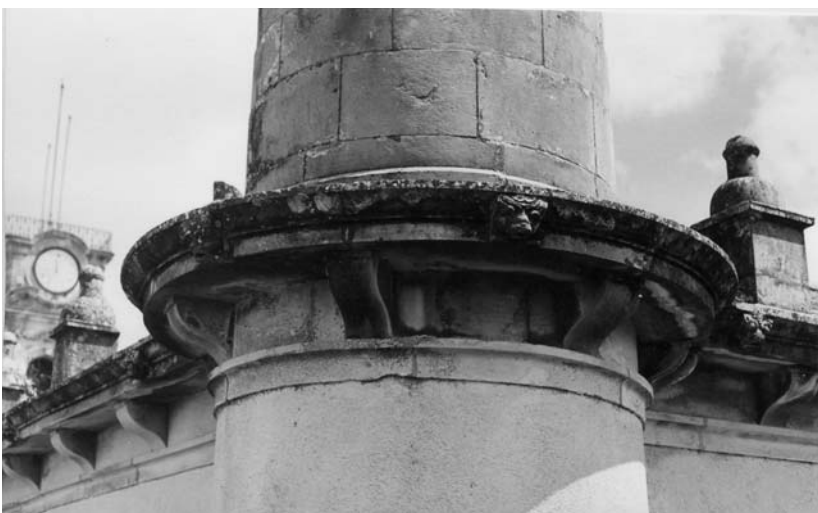
Detalhe da cornija modilhonada em torno do contraforte de sudoeste.
