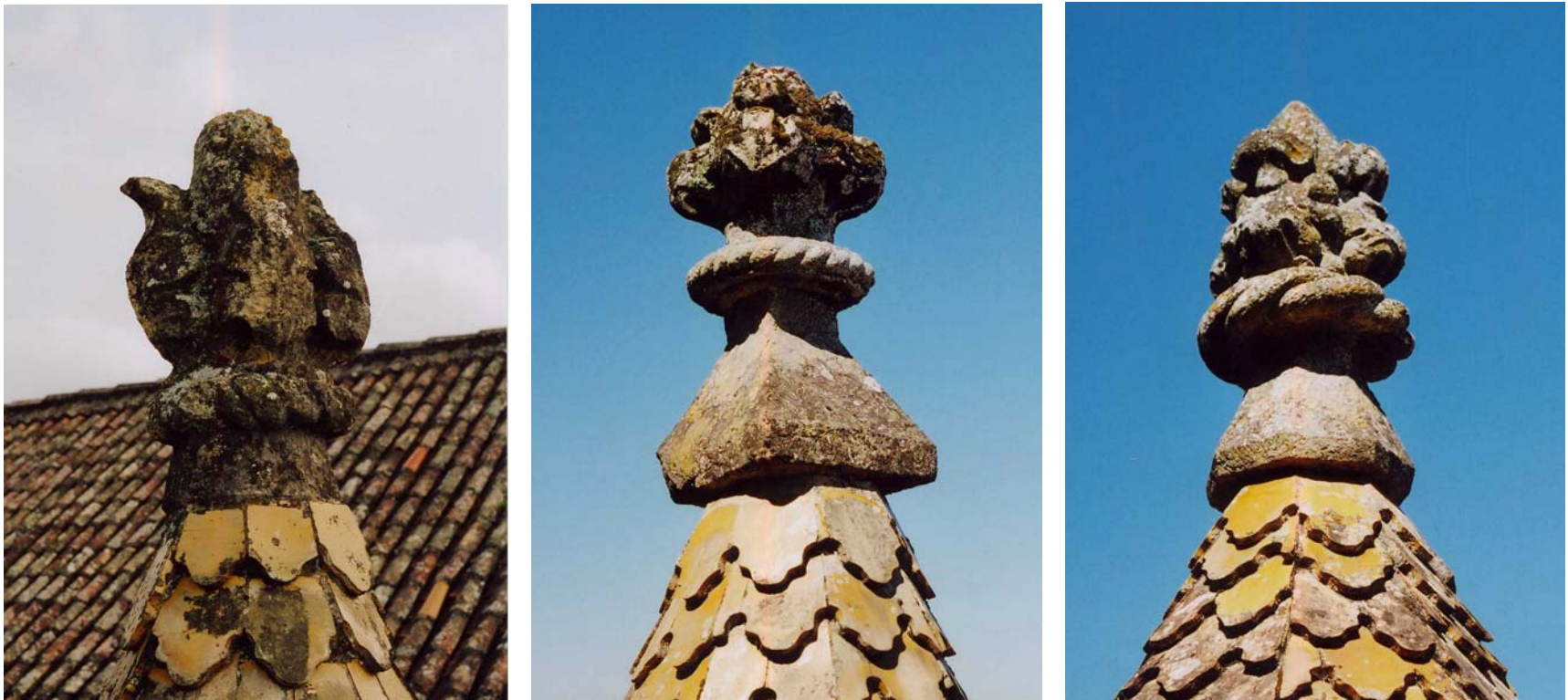
Detalhes do coroamento dos 2º, 3º e 4º cubelos (sentido este/oeste).
