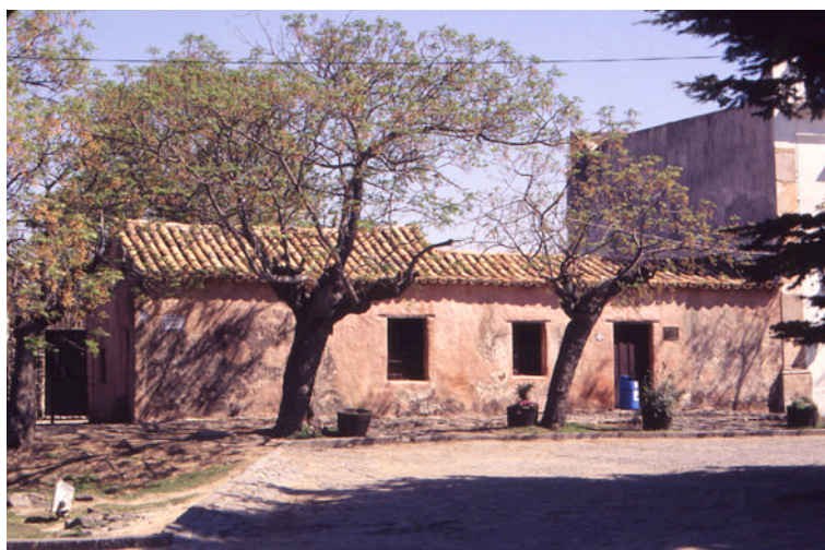
Construções do período de ocupação portuguesa, Colônia do Sacramento
