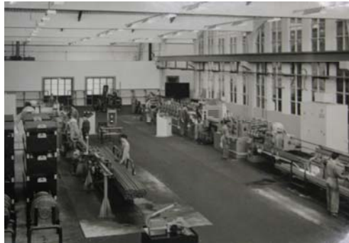
Fig.35, Fig.36 Piso 0 da Fábrica de Tubos. Área de produção.
