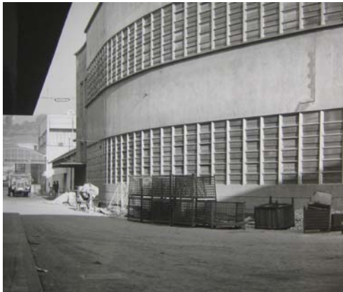
Fig.6 Arruamento principal 1ºplano Armazém de fundidos 2ºplano Fábrica de Máquinas de Costura
