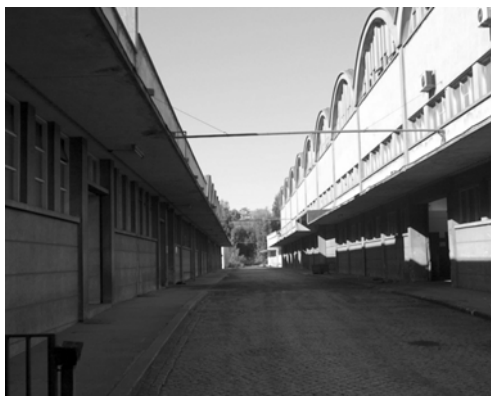
Fig.39, Fig.40 Alçado da rua da Fundição dos Armazéns Gerais
