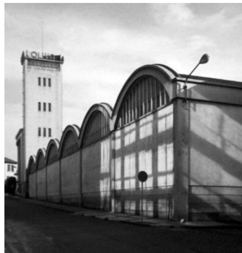
Fig.53 Cobertura da Fábrica de Tubos e da Fábrica de Máquinas de Costura.
