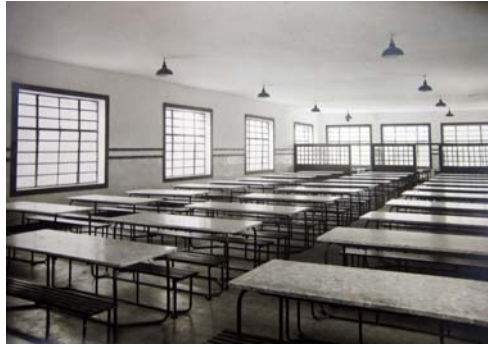
Fig.27 Piso 1 do edifício da portaria, escritórios e cantina. Cantina.
