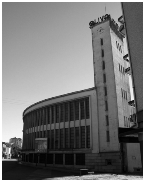
Fig.31, Fig.32 Alçado da rua da Fundição da Fábrica de Tubos.
