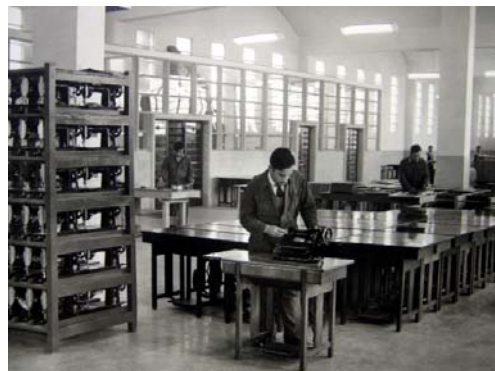
Fig.9 Interior da secção de mecânica da Fábrica de Máquinas de Costura. Em obras.
