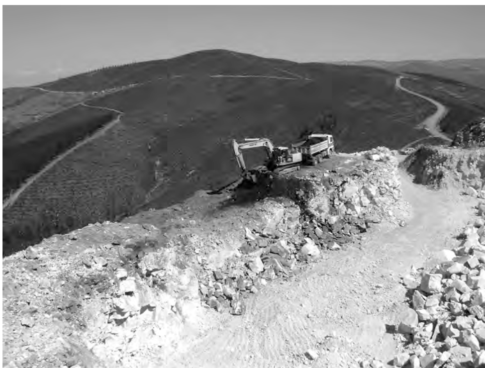
Figura 6 – Aspecto dos trabalhos na Mina da Argemela.
