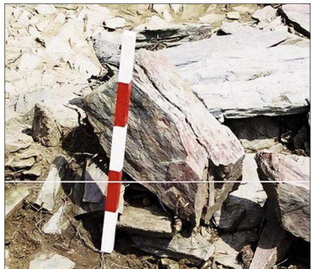
FIGS. 17 E 18 – Pormenores do estalamento de lajes dos “bastiões” B (em cima) e C (em baixo).
