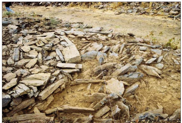
FIGS. 20 E 21 – Exterior do “bastião” B / sistema de contrafortagem.
