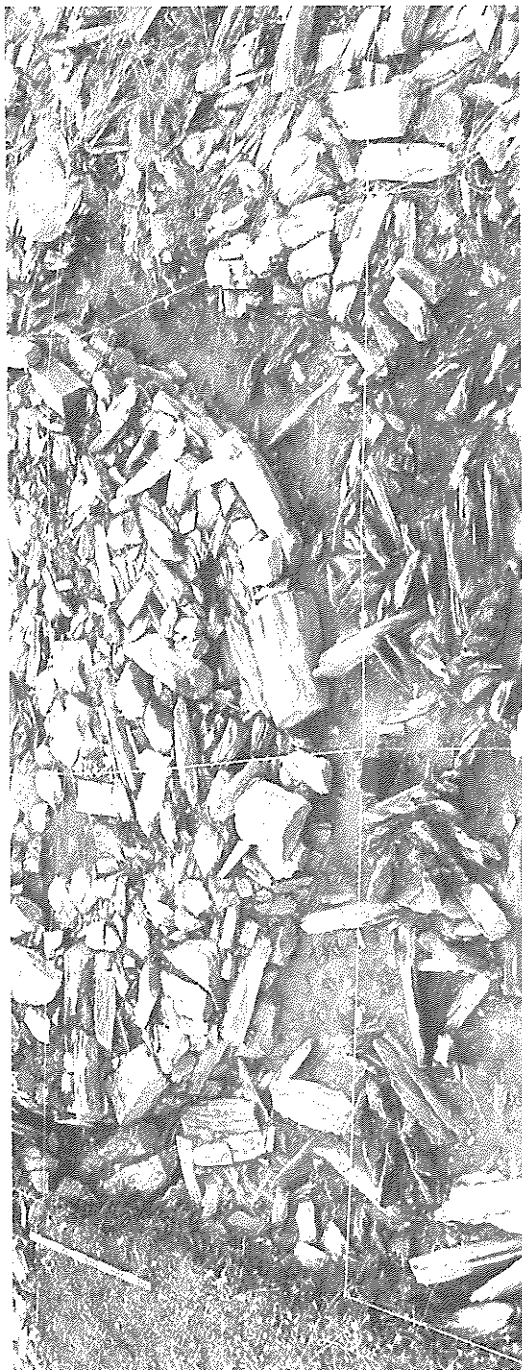
Foto 2 – Sistema, com lajes radiais e outras, de contrafortagem externa do “Bastião B” (foto João Muralha).
