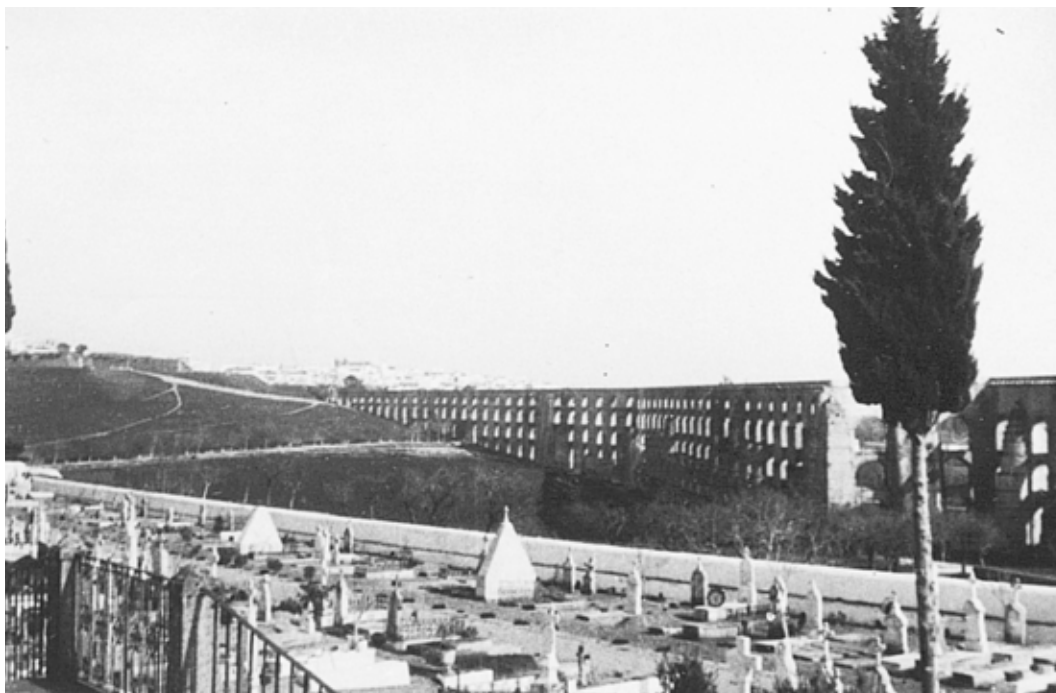
14. Antepiano de Urbanização da cidade de Elvas - Vista da zona exterior às muralhas | 1949.
