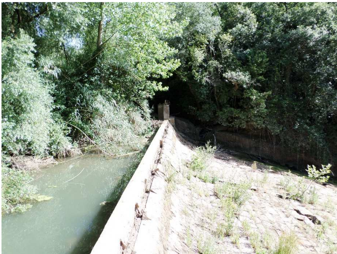
Figura 4. Açude da Fervença, Maiorga. Fonte: R. Rasquilho
