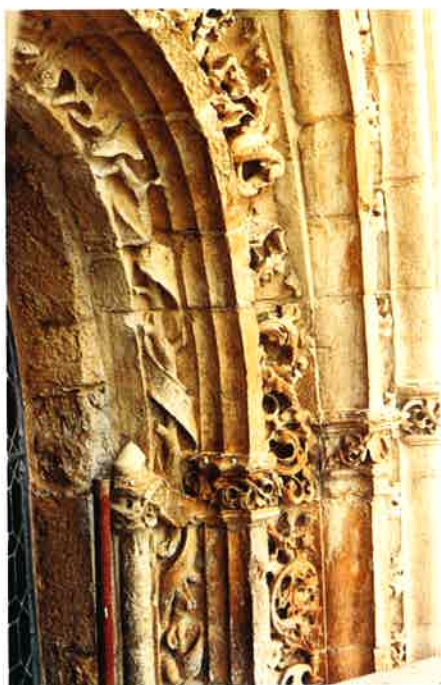
Fig. 17. Fachada de Santa Cruz. Janelão.
