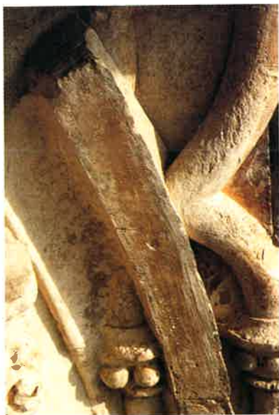
Fig. 30. Fachada de Santa Cruz. Molduras interrompidas sobre o arco do janelão.
