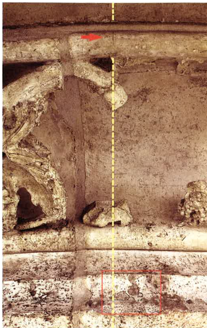
Pedra de fecho. É visível a incisão na superfície correspondente ao eixo do arco.
