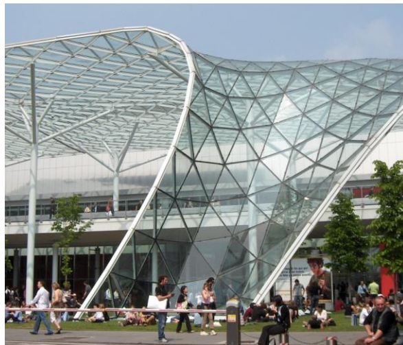
Fig. 14 – Cobertura dos espaços de circulação exterior na Fiera Milano
