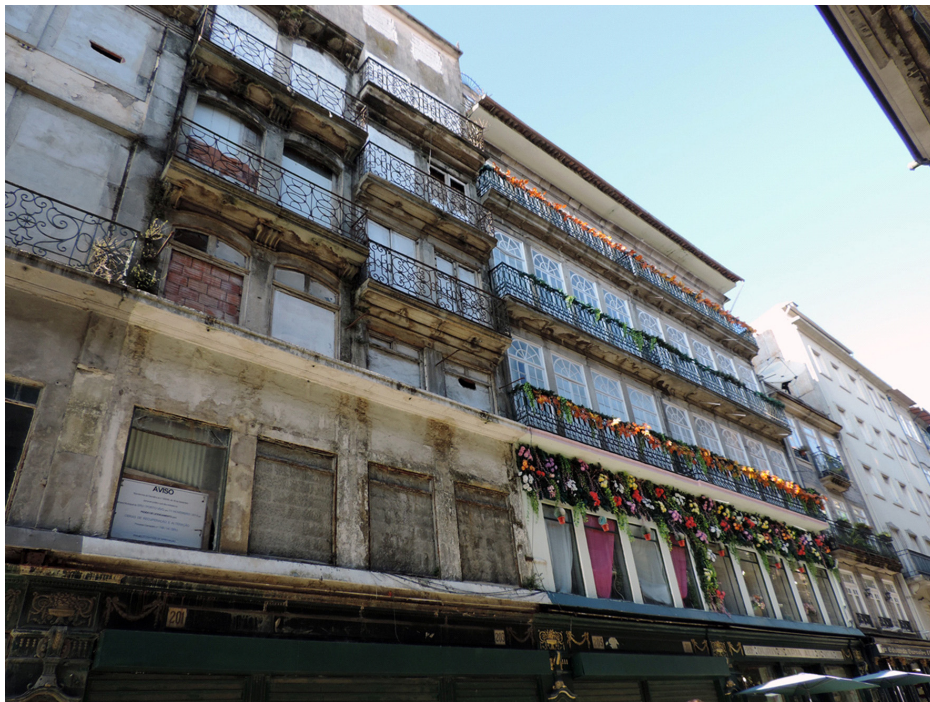
FIGURA 3: Intervenções fachadistas promovidas pela SRU Porto Vivo. Foto: Andréa Sampaio, 2015.
