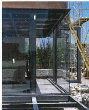
Figura 7. Foto da obra com estrutura em aço da cobertura e da esplanada à vista.
