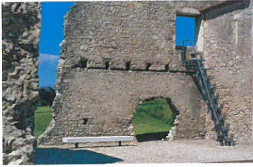
Figura 11. Ruína do Paço das Infantas e escada metálica de acesso a vão superior. Foto de João Mendes Ribeiro.
