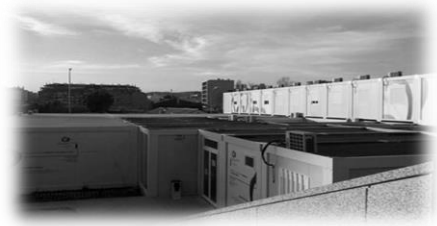
Tribunal de Loures. Instalações Provisórias (2015)
