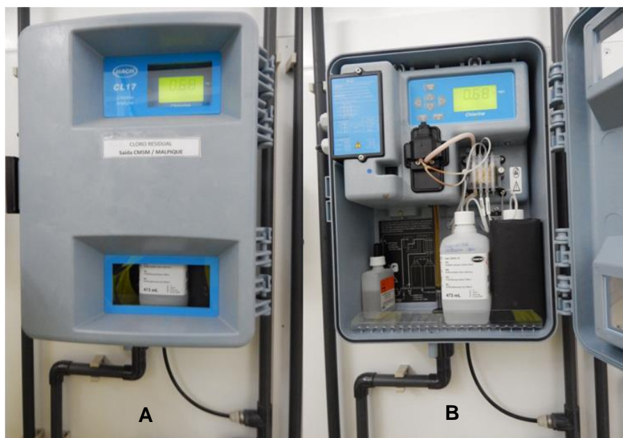
Ilustração 16 – Analisador de Cloro HACH - CL17 – (A) – Vista fechada; (B) – Vista interior. (Fonte EPAL)
