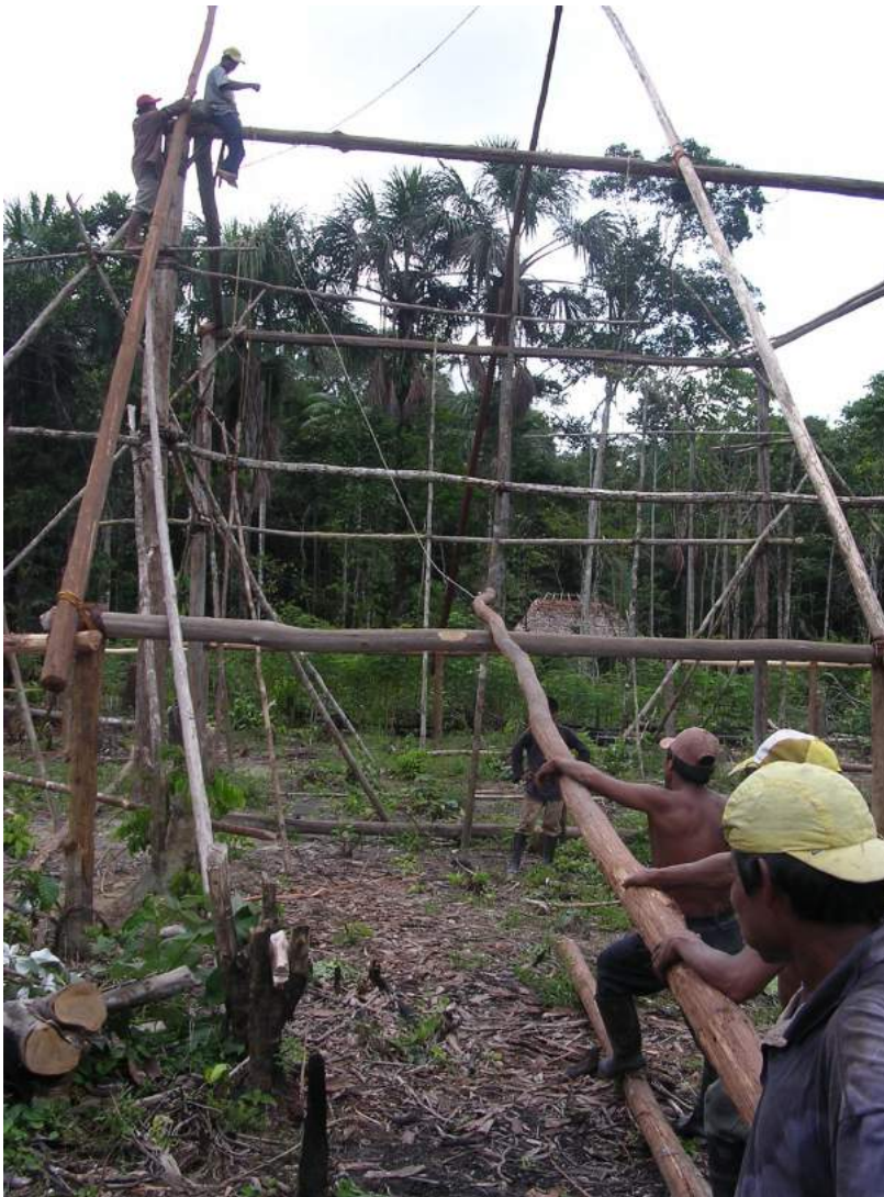
Figura 2 - La construcción de una maloca en el resguardo indígena Tikuna-Uitoto Kilómetro 6 y11.
