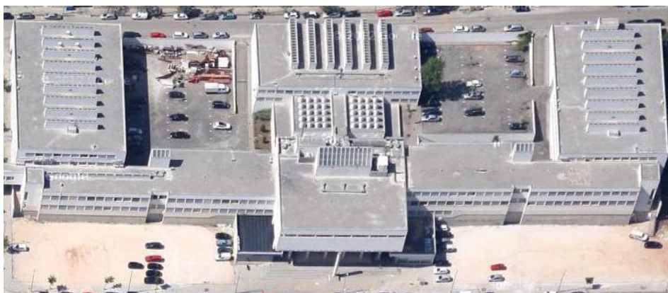
Figura 9 - Vista aérea do DEC [8]
