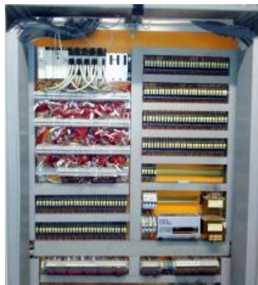
Figura 2 - Armário do autômato TSX P57-2634M
