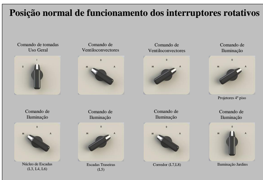
Figura D.35. Posicionamento dos interruptores rotativos de comando do piso 0 da torre T
