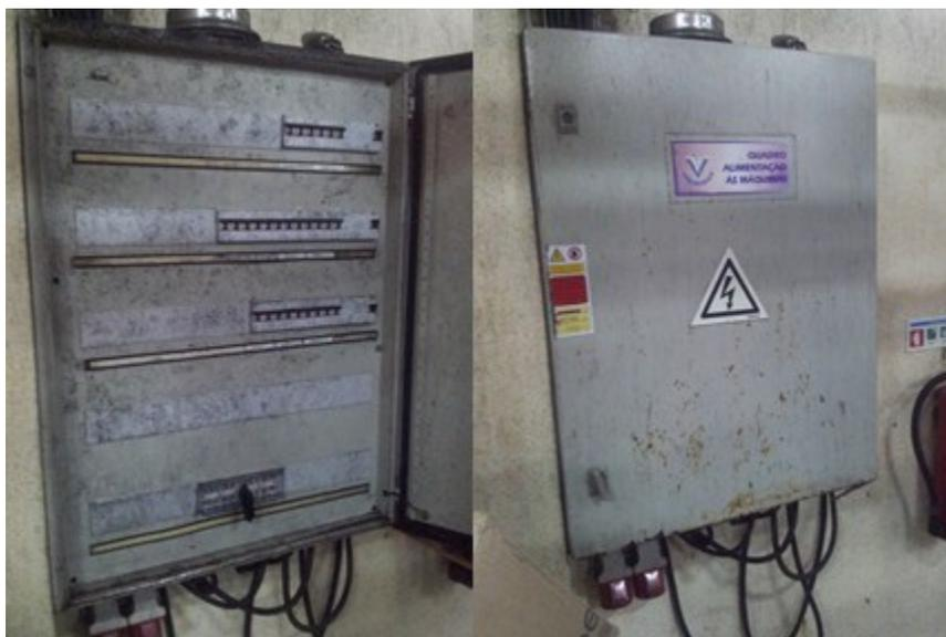
Fig. 13 - Quadro parcial em claro estado de degradação, oxidação evidente.
