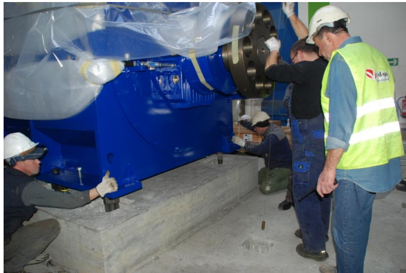
Figura 5.3. Posicionamento do alternador.
