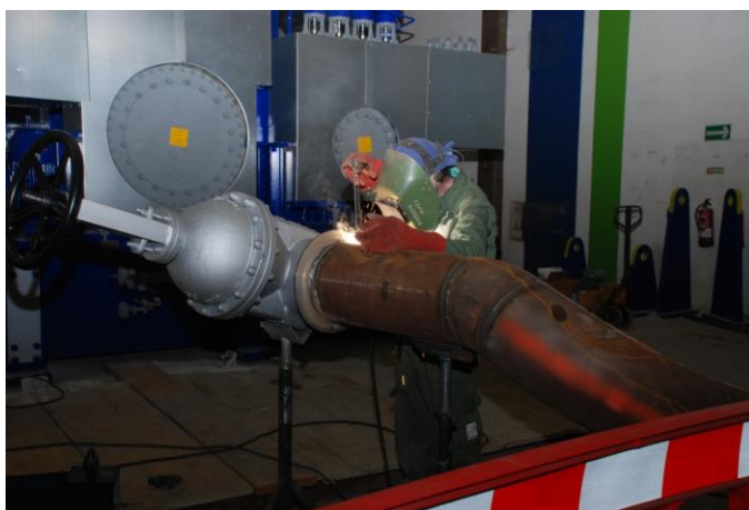
Figura 5.5. Execução Tubagens de vapor.
