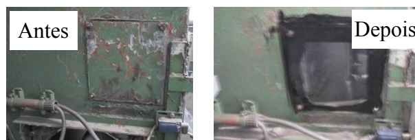
Figura 6.2. Aplicação de acrílico no elevador de canecos
