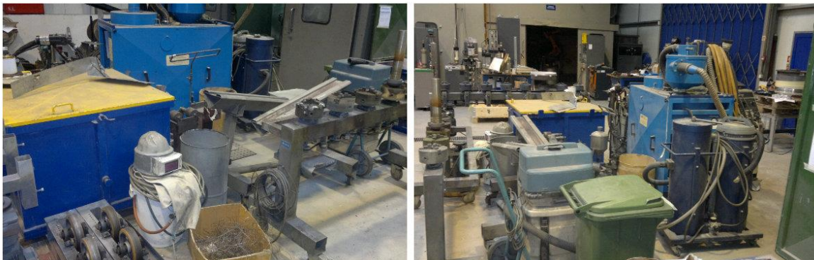
Figura 3.2. Área dos equipamentos de apoio à projeção (Estado inicial).
