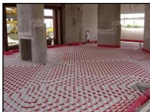
Figura 29: Imagem da instalação da tubagem do piso radiante
