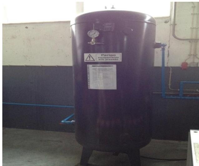
Figura 15 – Reservatório de ar comprimido
