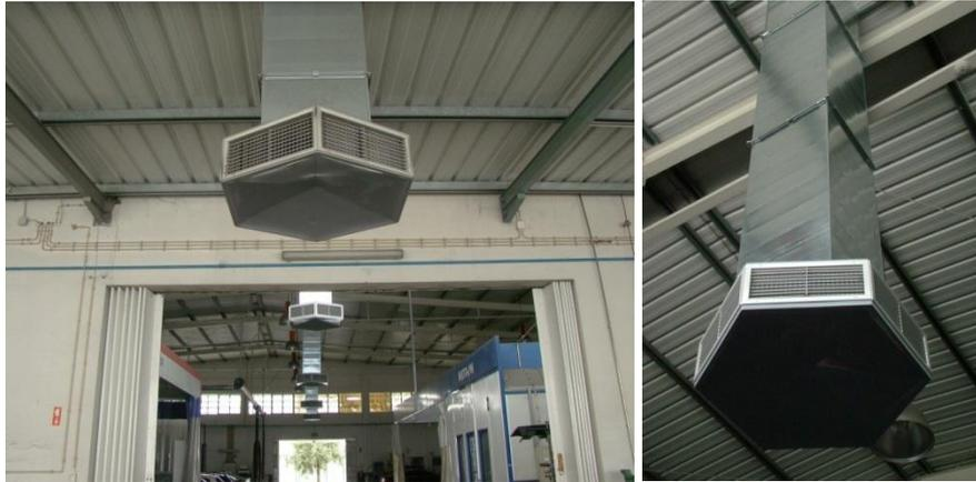
**Figura 30 – Conjunto de 5 ar condicionados evaporativos (esquerda), vista pormenorizada de um (direita)**
