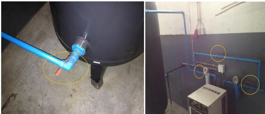
Figura 45 – Torneiras que fazem ligação ao reservatório (esquerda) e ligam o reservatório à rede (direita)
