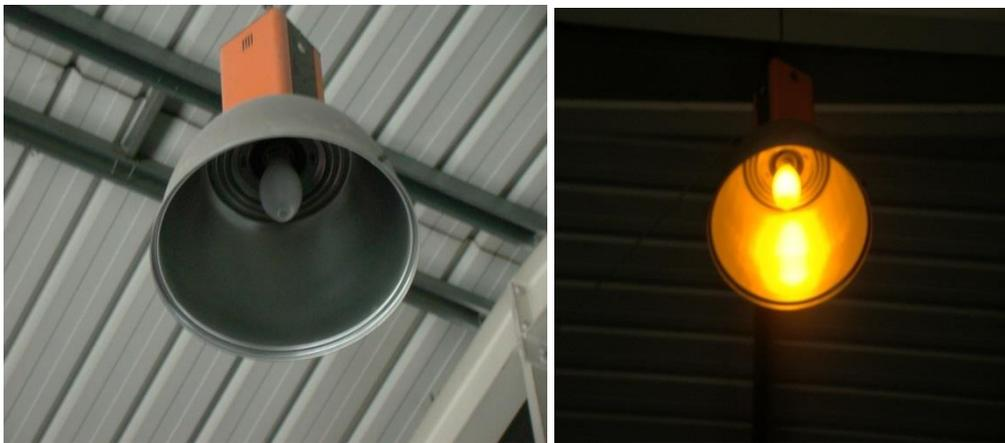
Figura 27 – Lâmpada de vapor de sódio com 250 W ligada (esquerda) e desligada (direita)
