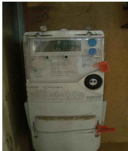
Figura 35 – Contador principal da energia elétrica
