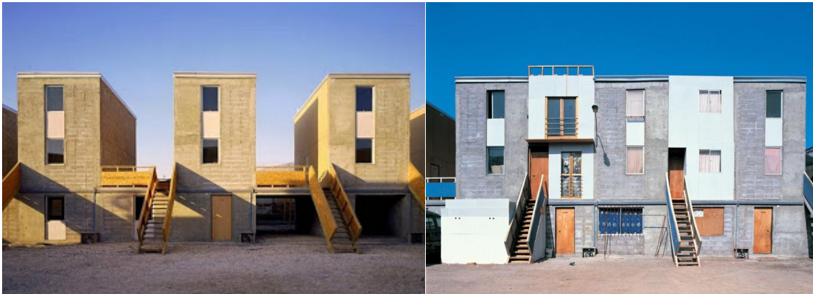
Figura 12: Conjunto em Iquique. Fonte: ArchDaily: Quinta Monroy / ELEMENTAL
