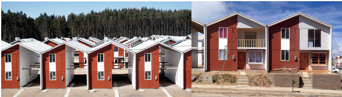
Figura 16: Conjunto Villa Verde. Fonte: ArchDaily: Habitação Villa Verde / ELEMENTAL
