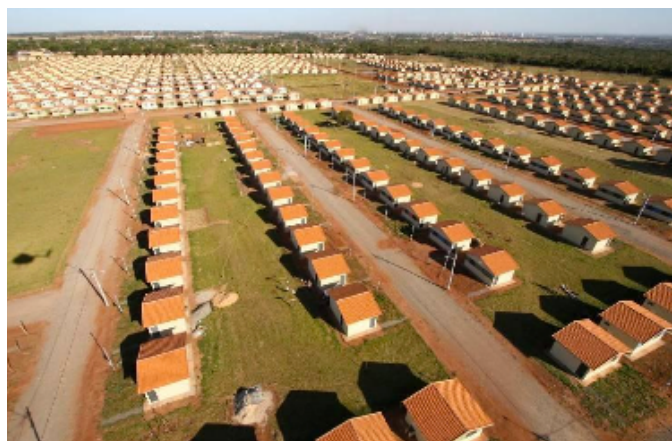
Figura 3: Conjunto habitacional executado pela prefeitura de Campo Grande. Fonte: cartilha “Política de Habitação de Interesse Social – ênfase na erradicação de favelas em áreas de risco e fundo de vale” – EMHA
