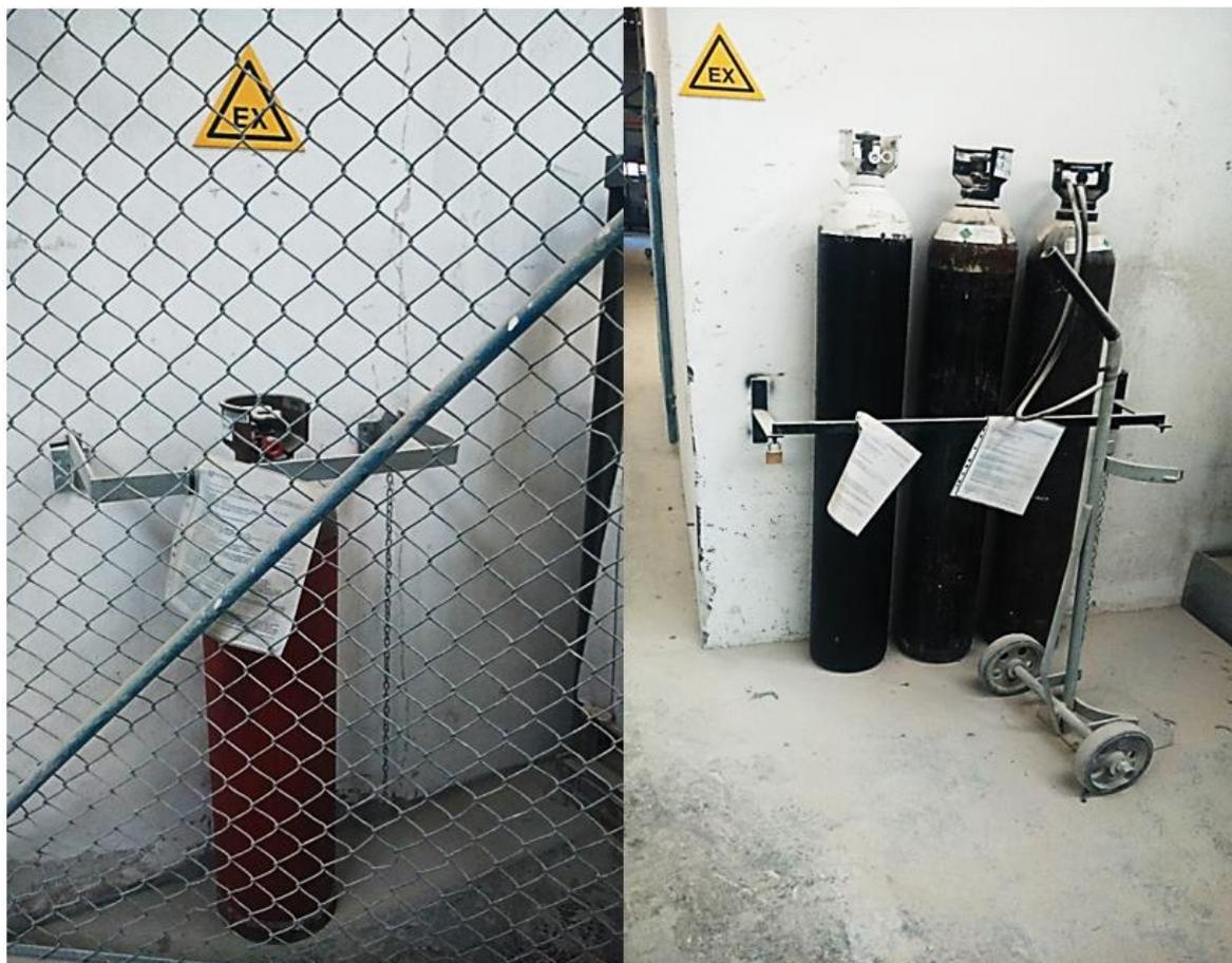
**Figura 4.13** Armazenamento de gases de soldadura. Acetileno (à esquerda), oxigênio e azoto (à direita)
