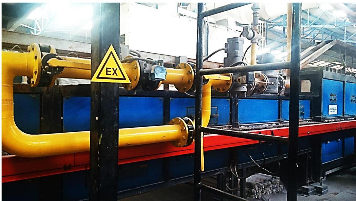
**Figura 4.11** Rampa de alimentação de gás do forno da Unidade 1 (Fonte: autor).
