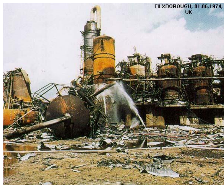
Figura 2.1 - Degradação dos depósitos após explosão.
