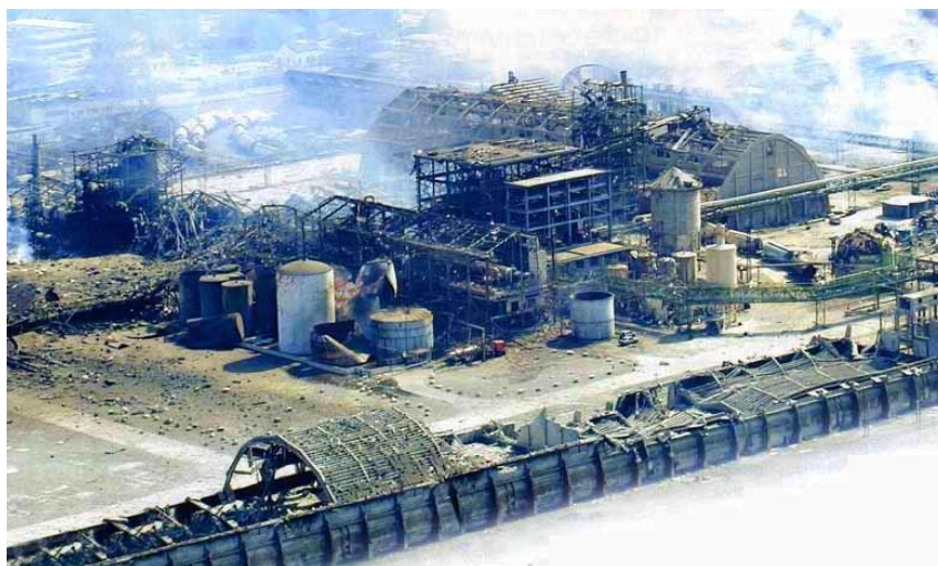
Figura 2.5 – Destruição da fábrica após a explosão.
