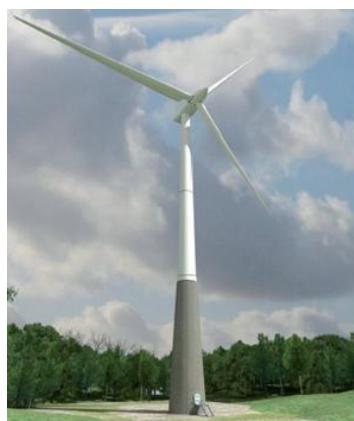
Figura 2-14 - Torre híbrida aço/betão (Reve, 2015).
