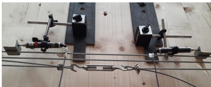
Figura 4-11 - Defletómetros instalados no cabo superior.
