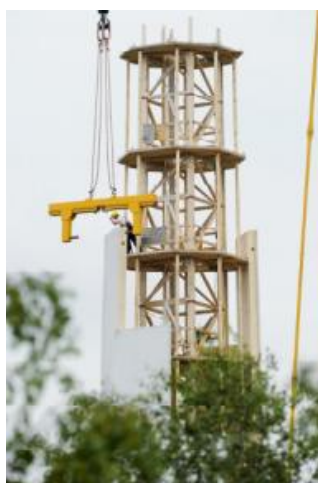
Figura 2-15 - Montagem da torre (TimberTower, 2014).
