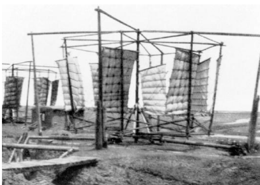
Figura 2-1 - Estruturas para bombeamento de água na China Antiga (Hau, 2006).
