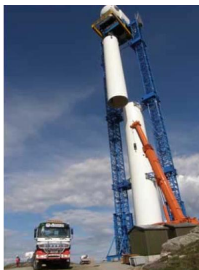
Figura 2-11 - Torre de elevação (Engström et al, 2010).
