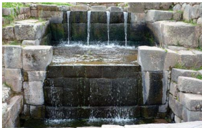
Figura 2.5 - Canal de drenagem pluvial de Machu Picchu (Turismo en el Perú@, 2011).
