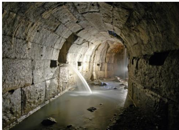
Figura 2.4- Canal subterrâneo da Cloaca Máxima (B_S_R@, 2015).
