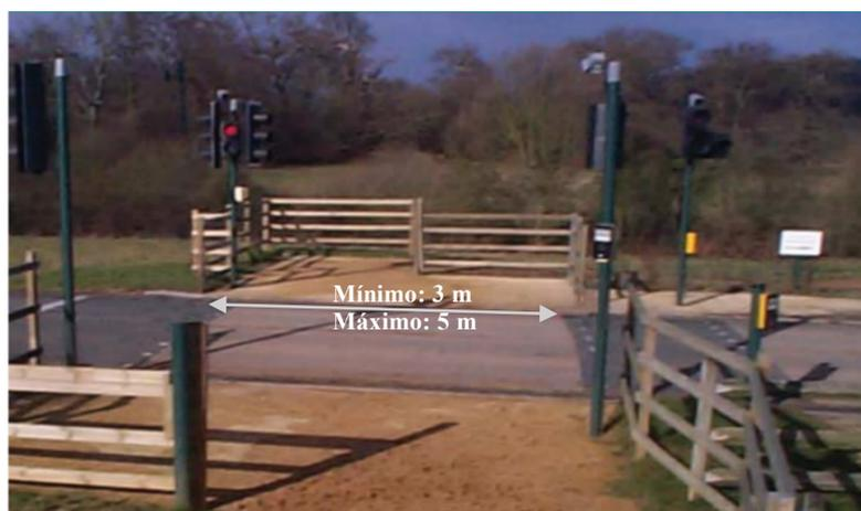
Figura 2.13 – Passagem do tipo *Pegasus* (Fonte: DfT, 2003)
