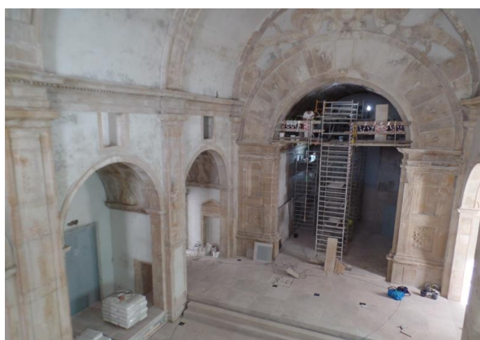
Figura 5.2 - Adaptação da igreja a auditório
