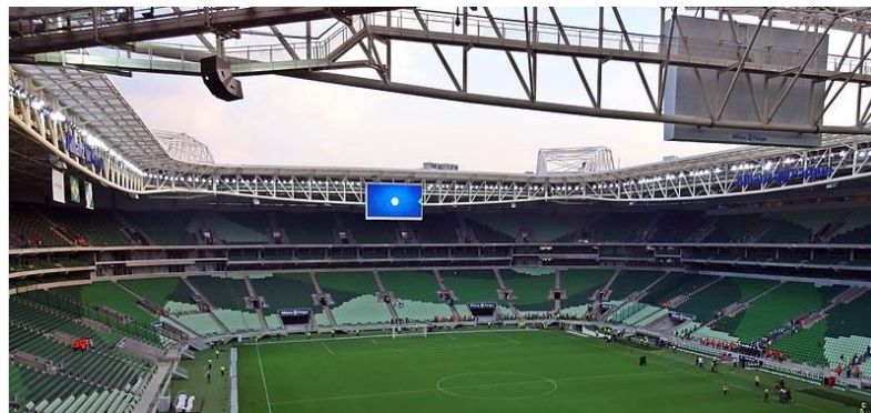
Figura 3.2 – No topo encontra-se uma passerelle para manutenção da cobertura (por exemplo para mudança de lâmpadas de iluminação) Fonte: http://www.conteudogeral.com
