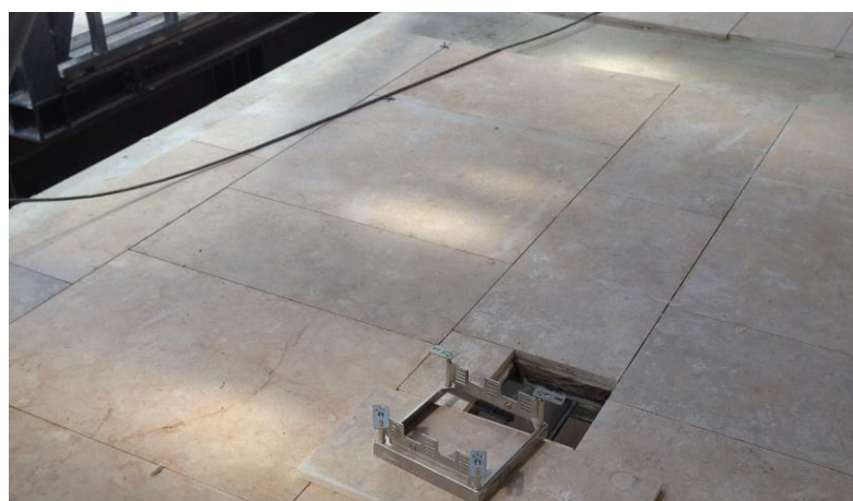
Figura 5.8 - Pavimento técnico modular
