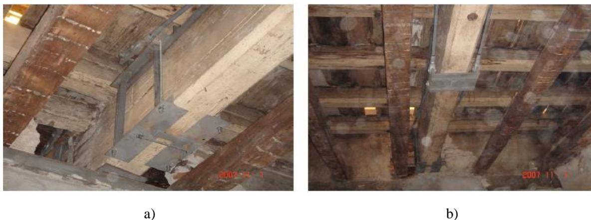
Figura 3.40 – a) e b) Exemplo de reforço de viga através de tirante metálico (Dias, 2008)
