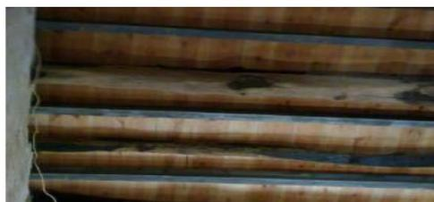
Figura 3.47 – Exemplo de reforço através da aplicação de vigas metálicas paralelas ao vigamento existente (T. Ilharco, 2008)
