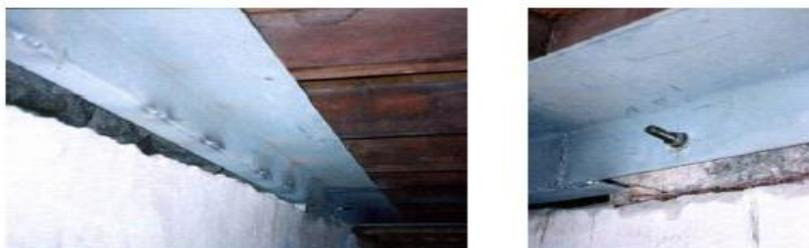
Figura 4.2 - Reforço de apoio através da colocação de cantoneira metálica entre a viga e a parede
