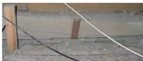
Figura 3.36 – Uso de cintas metálicas para reforço de vigas no Convento de Corpus Christi, Vila Nova de Gaia (Ilharco;2008)
