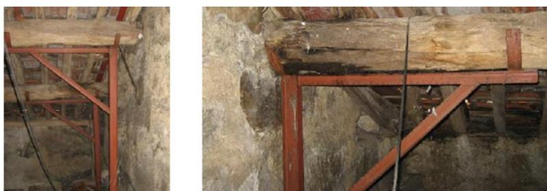
Figura 4.3 – Reforço de apoio através da colocação de cachorro metálico (Costa 2008a)
