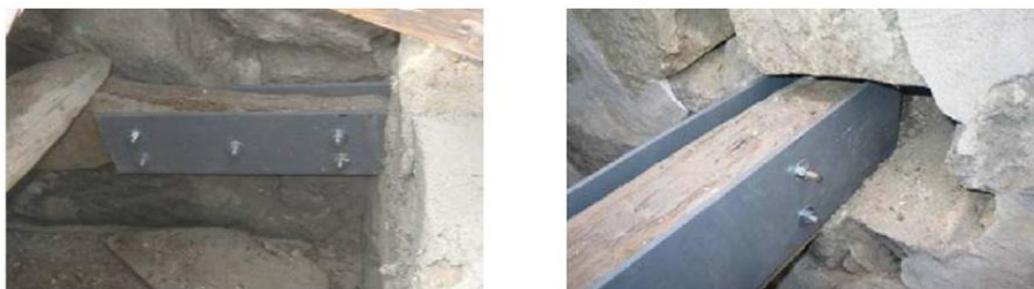
Figura 4.4 - Reforço de apoio através da fixação mecânica de chapas metálicas nas faces (T. Ilharco, 2010 b)
