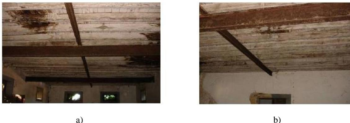
Figura 3.48 - Exemplo de reforço através da aplicação de vigas metálicas perpendiculares ao vigamento (T. Ilharco, 2008)
