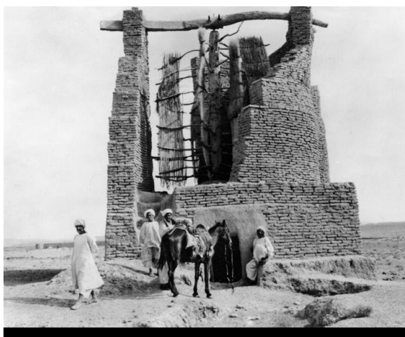
Figura 2.1 - Moinho de vento de eixo vertical para moagem de cereais, Afeganistão (Hau,2006)
