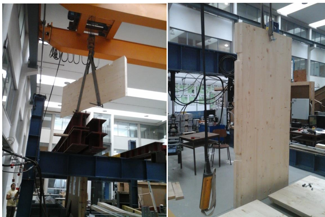
Fotografia 4.8 - a) Transporte dos painéis em laboratório; b) Elevação dos painéis para disposição hexagonal
