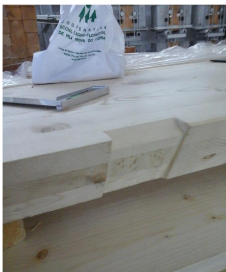
Fotografia 4.3 - Exemplo de entalhe para desviador de plataforma realizado
