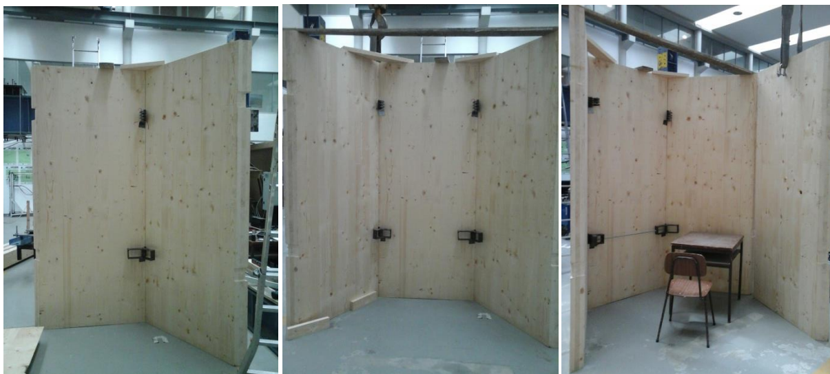
Fotografia 4.9 - Sequência de montagem da aduela de torre eólica em CLT
