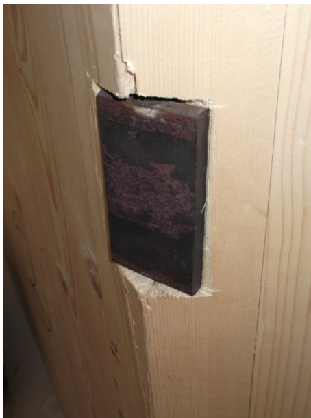
Fotografia 5.2 - Vista da junção da chapa de topo do desviador com a superfície da madeira
