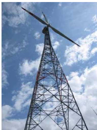
Figura 2.7 - Torre treliçada (Engström et al. , 2010)
