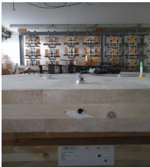
Fotografia 4.4 - Varão de aço colocado perpendicularmente ao plano do painel
