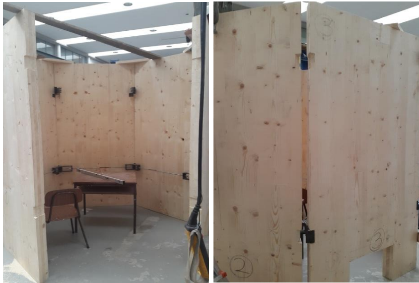
Fotografia 4.10 - Continuação da sequência de montagem
