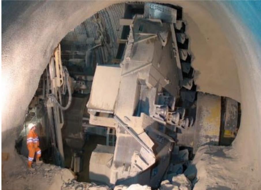
Figura 3.7 – *Reamer* TBM utilizada no alargamento e no túnel piloto do Túnel de Uetliberg, Zurique, Suíça (Aker Wirth GmbH@, 2005).
