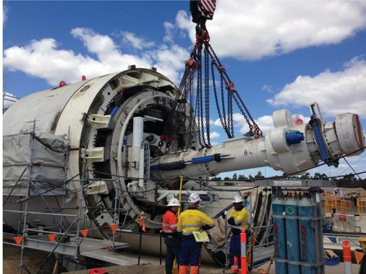
Figura 4.6 – Montagem do “sem-fim” da EPBM construída para a escavação de um túnel da Australia’s Anglo-American Coal Mine (trenchlessonline@, 2014).
