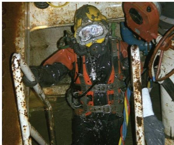
Figura 4.17 – Operário equipado com equipamento de mergulho para efectuar manutenção na cabeça de corte de uma Mixshiled TBM (tunnelonline@, 2013).
