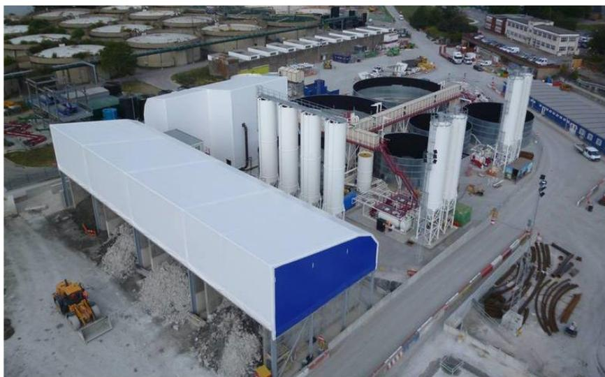
Figura 4.11 – Estação de tratamento de lamas da SFM construída para escavar o Túnel “Water Lee” sob o rio Tamisa para o projecto “Crossrail”, Londres, Reino Unido (MS SA@, 2014).
