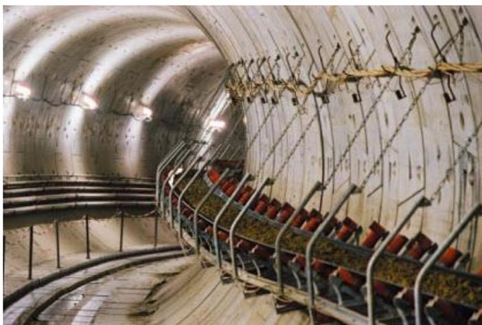
Figura 2.14 – Transportador de correia desenvolvendo-se ao longo do alinhamento de um túnel (Herrenknecht AG@, 2013).
