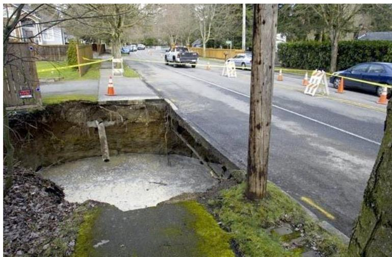
Figura 4.1 – Subsidência devido à abertura de um túnel (TunnelTalk@, 2009).
