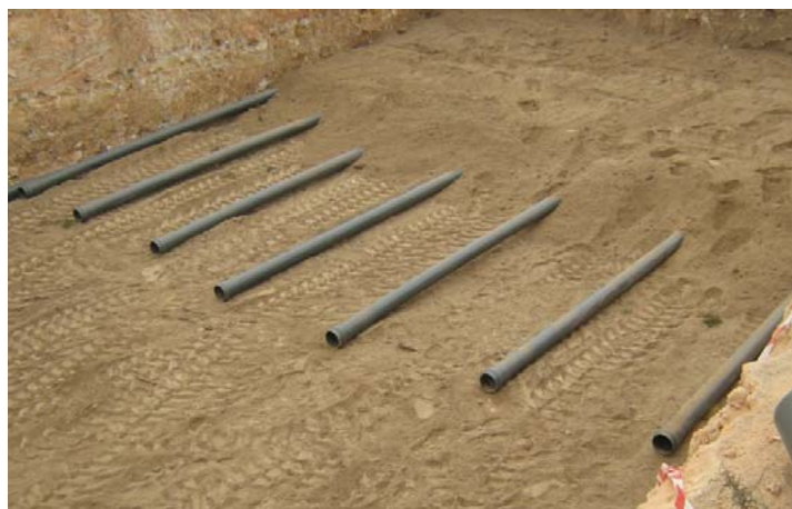
Figura 4.3 – Instalação das tubagens no solo
