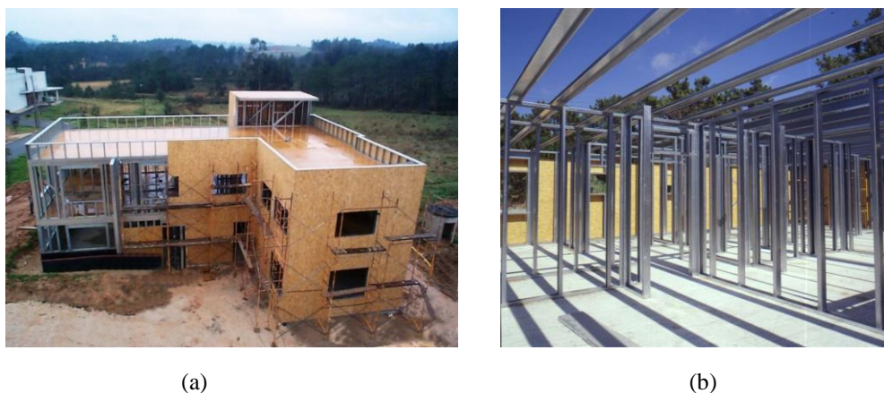
Figura 2.1 – Exemplo da utilização de perfis em aço enformado a frio nas construções modulares.(a) [6] e (b) [6]
