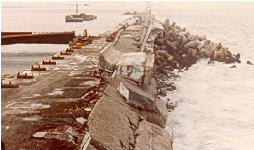
Figura 2.4 - Molhe oeste do porto de Sines depois das tempestades, Fevereiro de 1987 (Neves, 2012)
