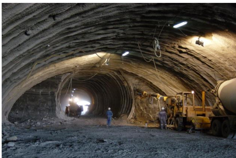
Figura 2.2 – Túnel construído sequencialmente de acordo com os princípios do NATM. Parcialização da secção transversal. (fotografia cedida pelo Prof. Almeida e Sousa).
