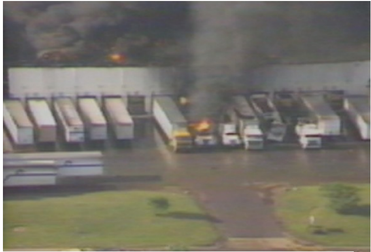
Fig. 2.12- Incêndio armazém de tintas da Sherwin – Williams
