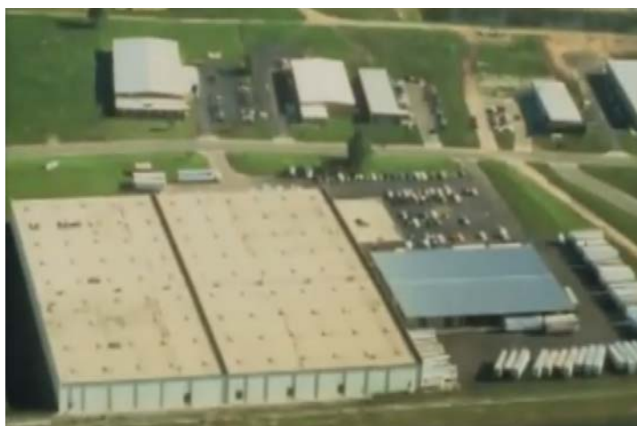
Fig. 2.8-Armazém de tintas da Sherwin – Williams
