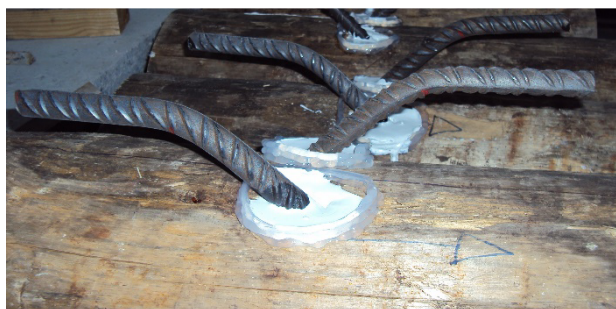
Figura 3.8 - Colagem dos ligadores inclinados na madeira.
