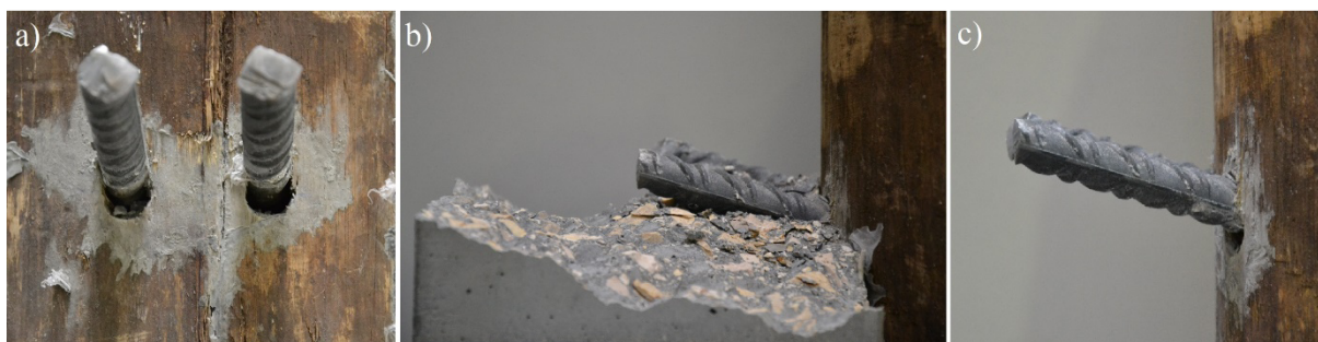
Figura 4.5 - a) Esmagamento da madeira na zona dos ligadores (provete CP90_14); b) deformação nos ligadores do plano inferior (provete CP90_13); c) esmagamento da madeira com aparente formação de rótula plástica nos ligadores (provete CP90_13).
