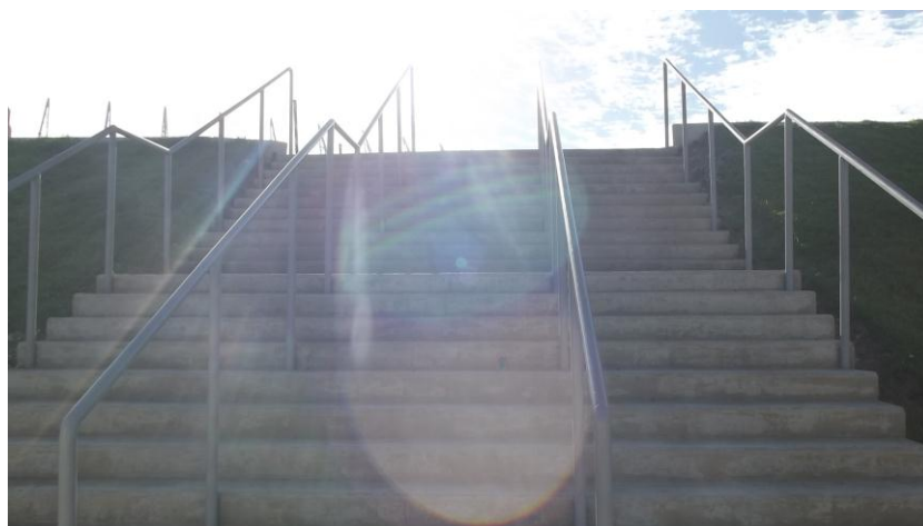
Figura 39 – Fotografia de um corrimão da escada do estádio.
