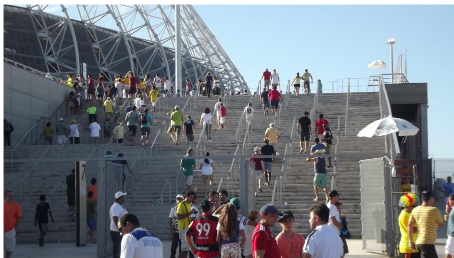
Figura 44 – Fotografia de uma escada de entrada do estádio com corrimões a 2,40 m.
