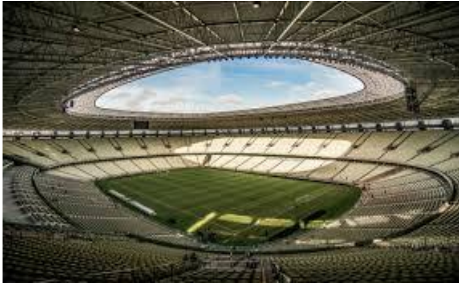
Figura 42 – Fotografia com visão geral da bancada do estádio.
