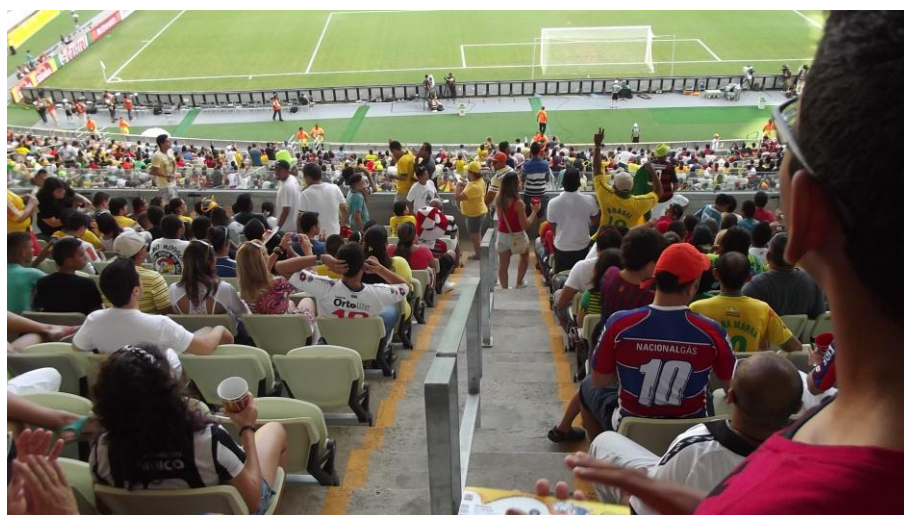
Figura 45 – Fotografia da bancada do estádio com um corrimão nos acessos radiais.
