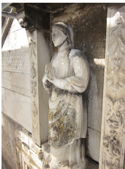
Figura 7.17: Resultado da ação de limpeza mecânica e permanência de crostas.
