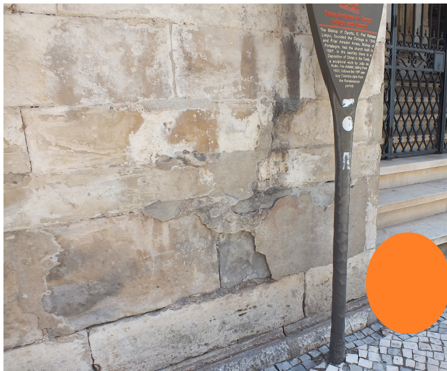
Figura A-3: Utilização de argamassas cimentícias.
