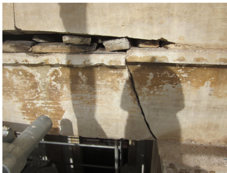
Figura B.6: Fratura.
