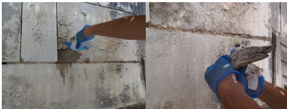
Figura 7.30: Execução de consolidação por colagem.
