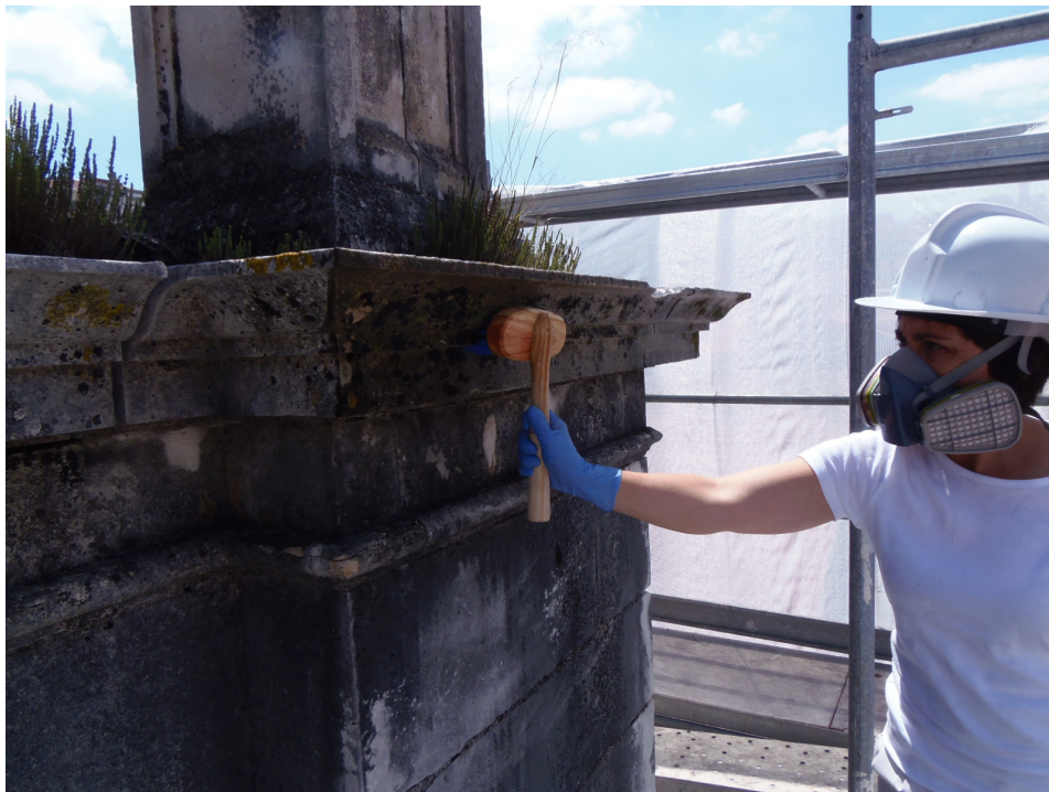
Figura C-3: Limpeza após aplicação de biocida. (fornecida por equipa de restauro).
