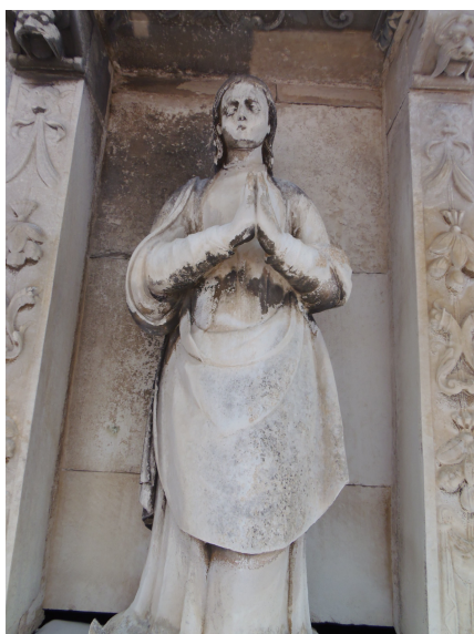
Figura 7.20: Limpeza por micro abrasão apenas do lado direito do nicho.
