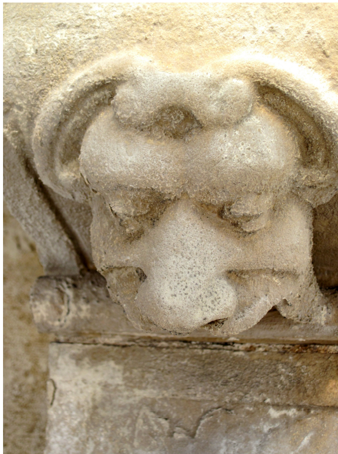
Figura B.5: Desintegração granular/ pulverização.
