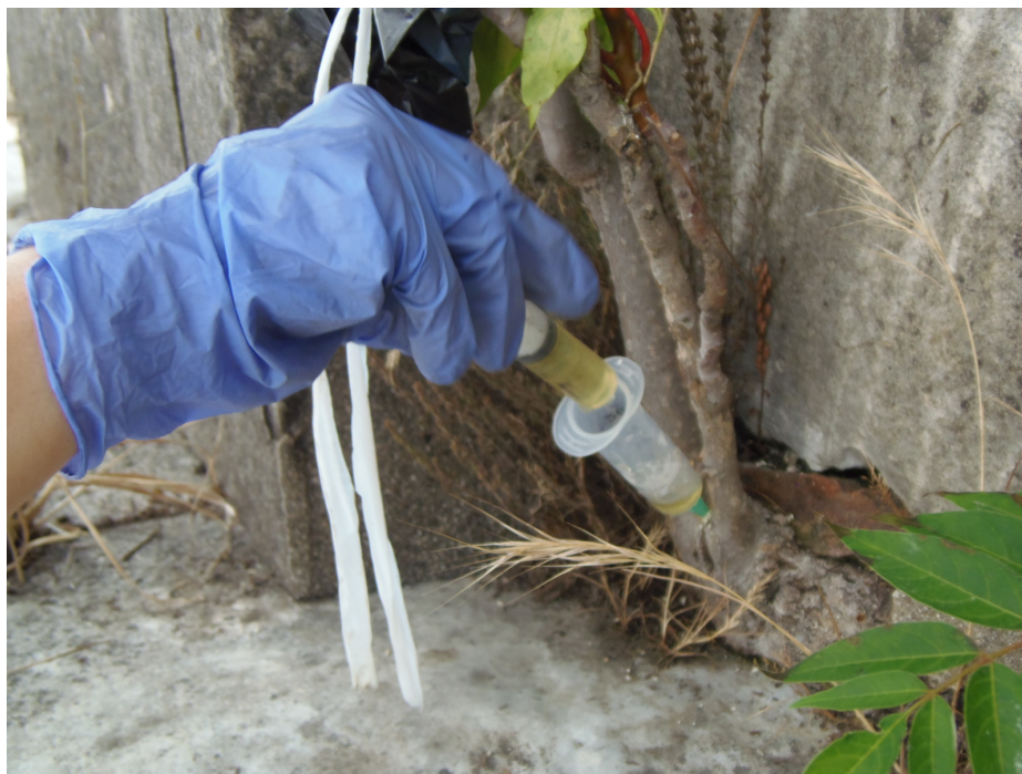
Figura C-6: Aplicação de herbicida através de injeção de seringas. (fornecida por equipa de restauro).
