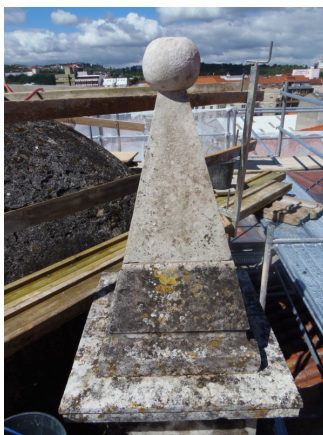
Figura 7.14: Pormenor da ação de limpeza efetuada na Igreja.
