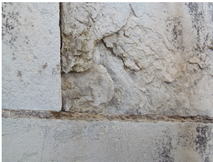
Figura C-12: Resultado final da consolidação. (fornecida por equipa de restauro).
