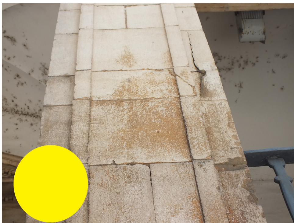
Figura A.5: Pátina e rutura pontual.
