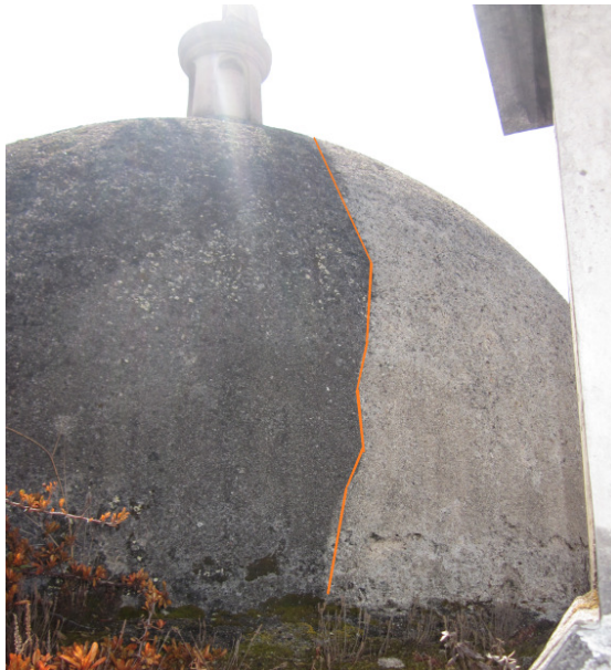
Figura 7.15: Limpeza do extradorso da cúpula da torre sineira da Igreja.
