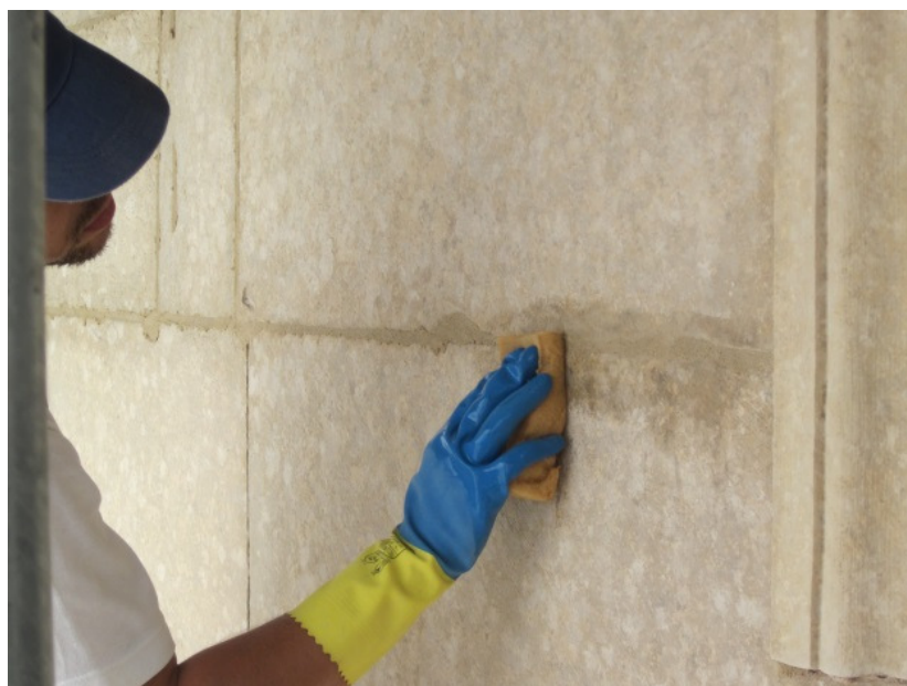
Figura C.14: Humedecimento de juntas após colocação de argamassa.
