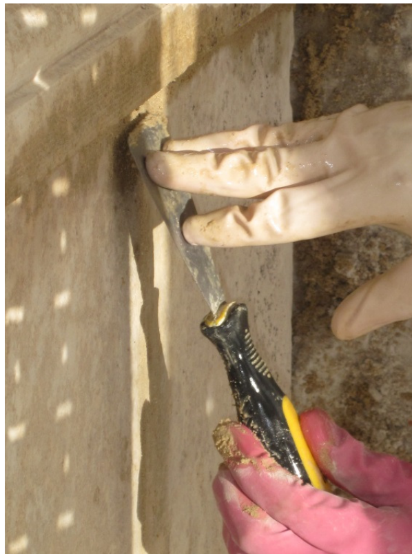
Figura C-13: Refechamento de juntas com argamassa.
