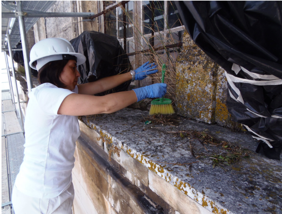
Figura C-7: Limpeza de sujidade depositada nas superfícies horizontais. (fornecida por equipa de restauro).
