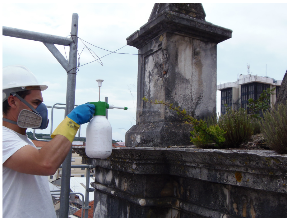
Figura C-2: Aplicação do herbicida. (fornecida por equipa de restauro).
