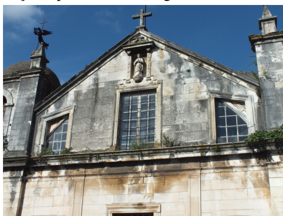
Figura 7.4: Zona superior da Igreja do Carmo.
