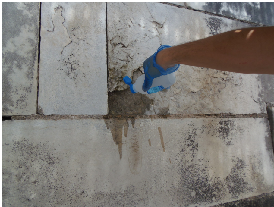
Figura C-11: Limpeza do suporte para a consolidação. (fornecida por equipa de restauro).
