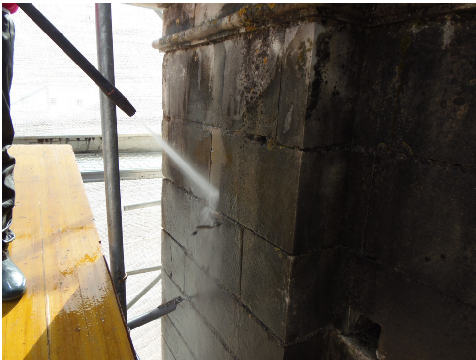
Figura C-8: Limpeza da fachada. (fornecida por equipa de restauro).
