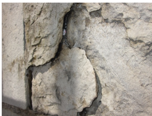
Figura 7.31: Resultado final da colagem com resina epóxi.
