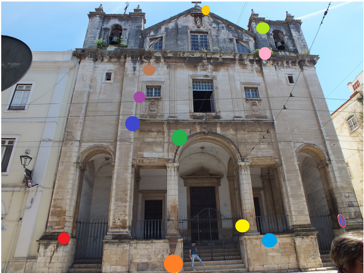
Figura A-1: Fachada da Igreja do Carmo antes de intervenção.
