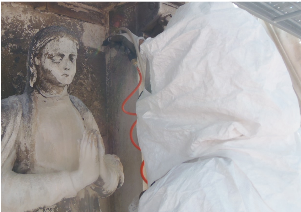
Figura C-10: Limpeza por micro-abrasão. (fornecida por equipa de restauro).
