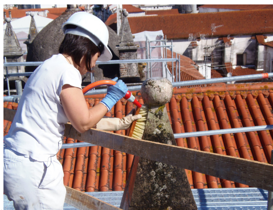
Figura 7.13: Trabalho de limpeza mecânica a baixa pressão na Igreja do Carmo.
