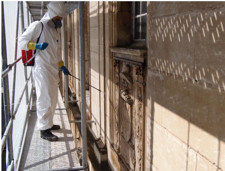
Figura C-1: Aplicação do biocida.(fornecida por equipa de restauro).
