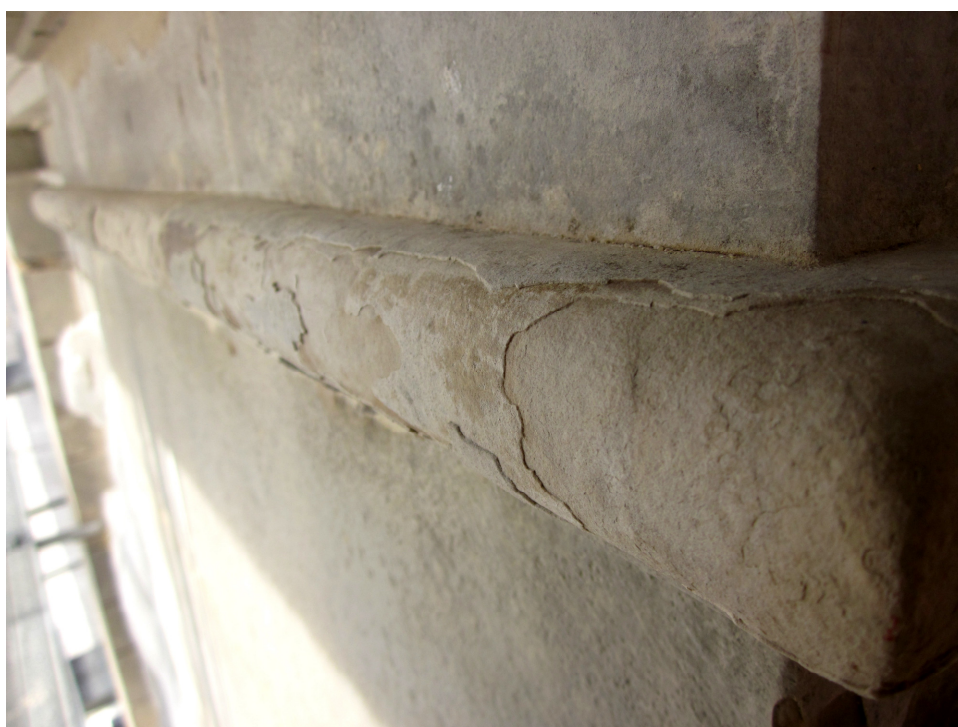
Figura B.2: Destacamento
