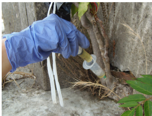
Figura 7.27: Introdução de seringas com herbicida no interior das raízes.
