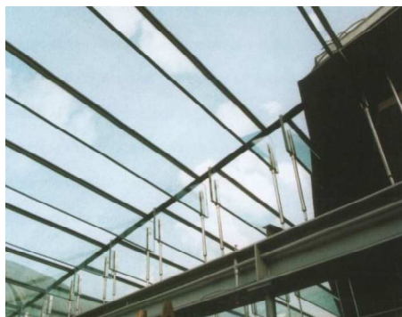
Figura 2.11 - Vigas de vidro num edifício em Budapeste (retirada de (Valarinho, 2010)).
