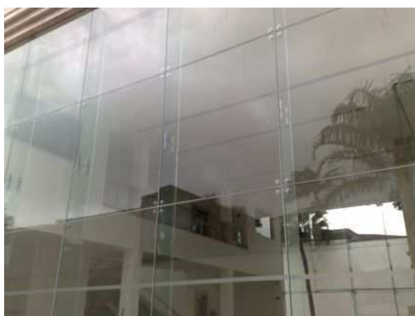
Figura 2.12 - Estrutura de glass fins num edifício da Citroen em São Paulo (retirado de (T2G@)).
