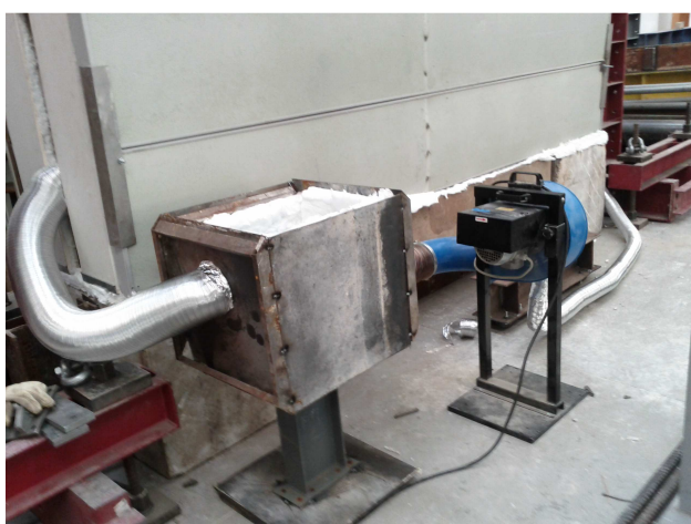
Figura 3.11 - Sistema de circulação e aquecimento do ar, o exaustor (de cor azul) e forno.
