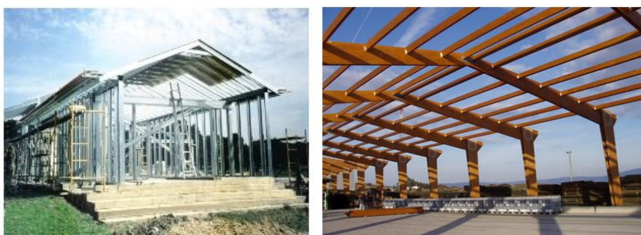
Figura 2.3 – Exemplo de construção leve em Light Steel Framing e em estruturas de madeira (Futureng, 2015 e Carmo, 2015)
