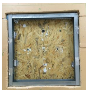
Figura 5.16 – Pannel de OSB e com chapa na sua envolvente e caixa-de-ar vazia (imagem obtida antes da aplicação da placa de OSB)
