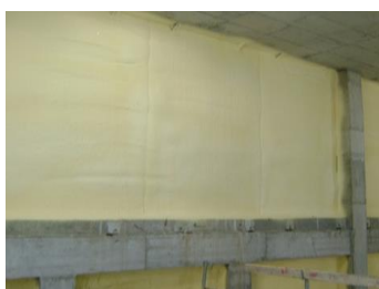
Figura 3.5 – Espuma de poliuretano projetado (Polirígido, 2015)
